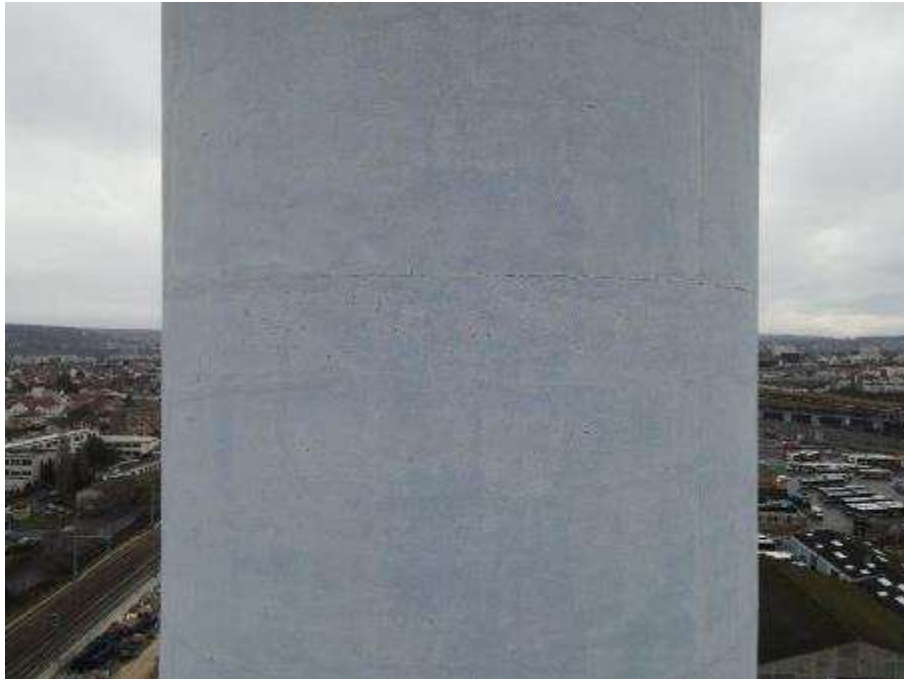
Photo n°69 : Fût béton en bon état, peinture légèrement passée.
