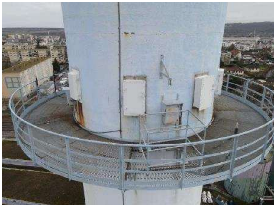
Photo n°46 : Passerelle en bon état
