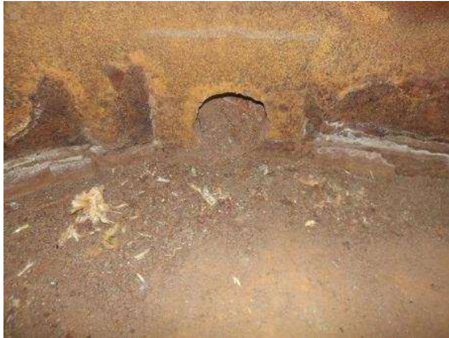
Photo n°160 : Evacuation des condensats en bon état.
