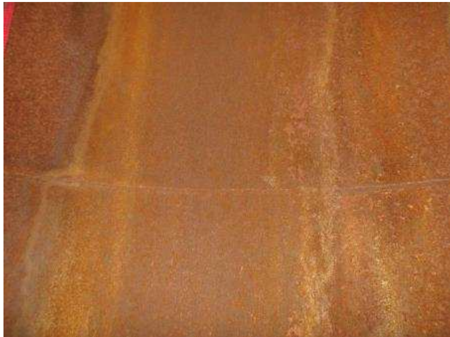
Photo n°161 : Conduit en bon état
