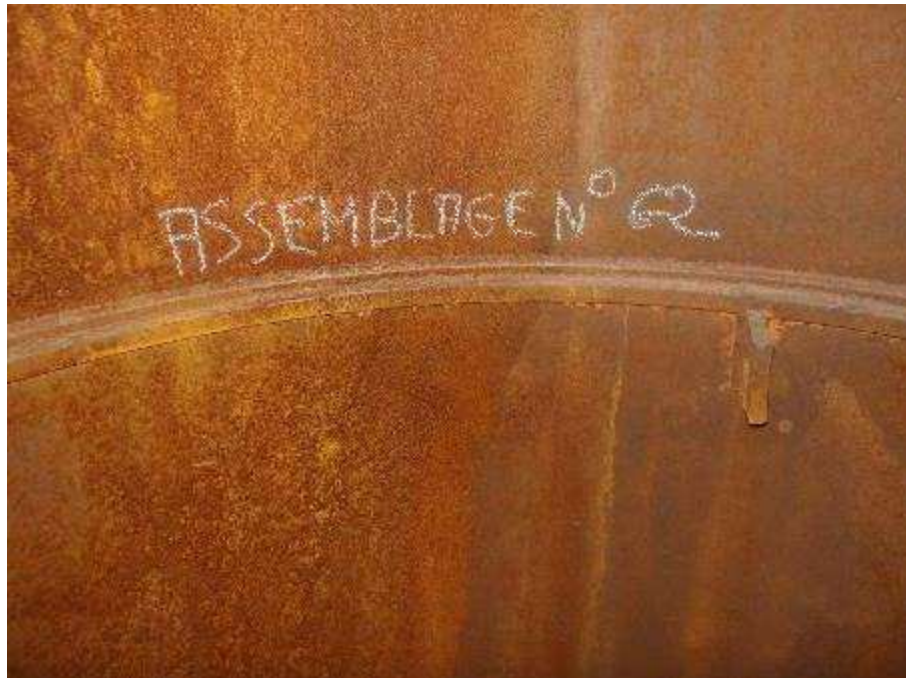
Photo n°163 : Assemblage et conduit en bon état
