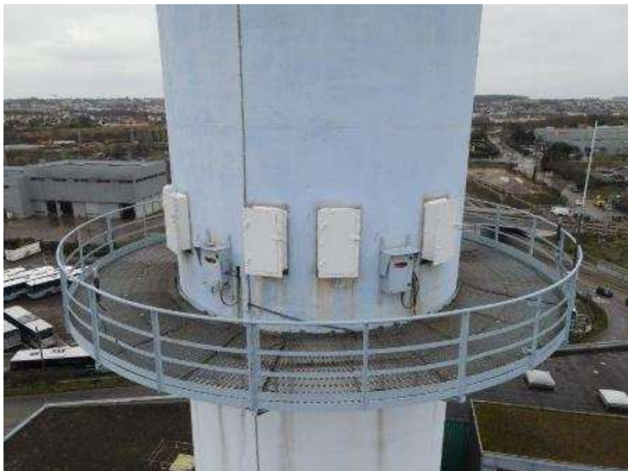
Photo n°16 : Passerelle en bon état, capotages des prises de mesures en bon état.
