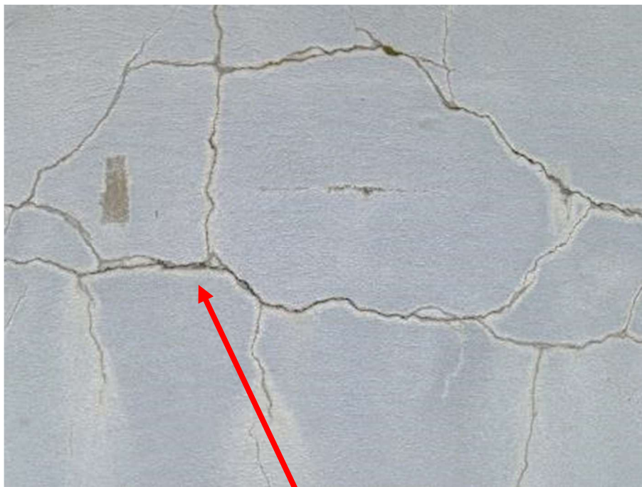
Photo n°8 : Fissuration importante du béton (ancienne réparation)
