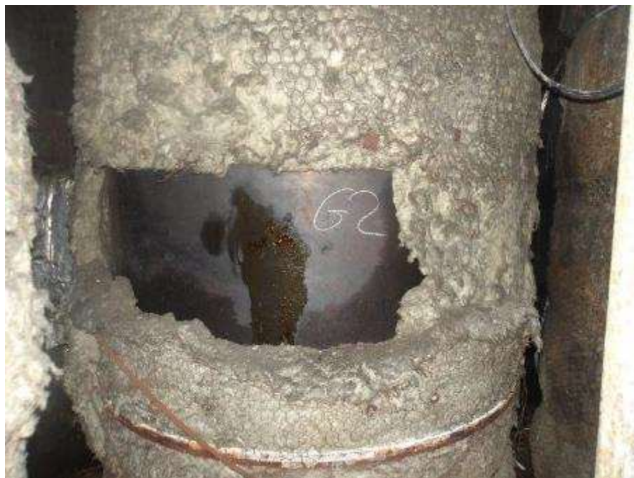
Photo n°101 : Isolant à reprendre (niveau passerelle)
