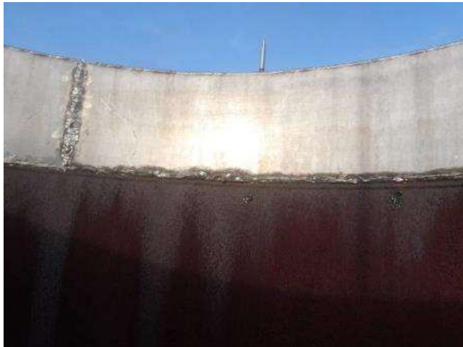
Photo n°249 : Bandeau inox sur 200mm au sommet du conduit en bon état
