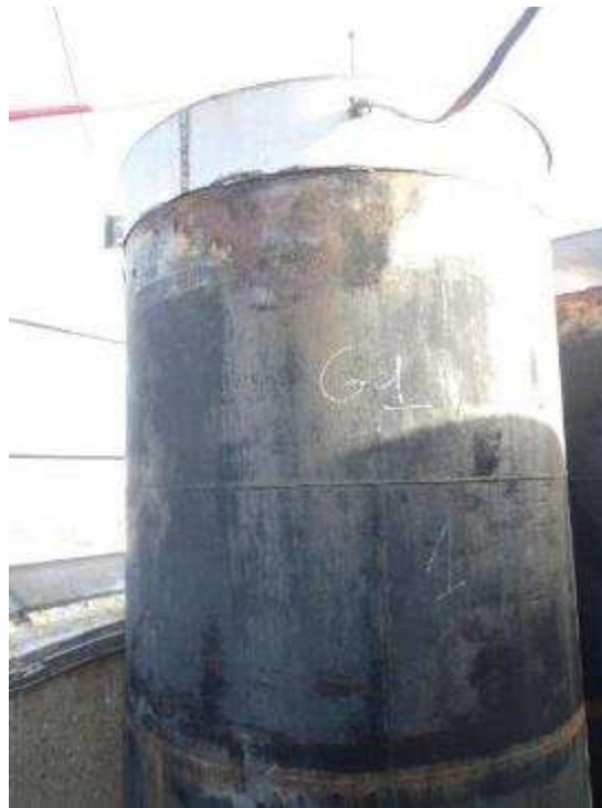
Photo n°143 : Fourreau de passage du conduit oxydé (à repeindre)
