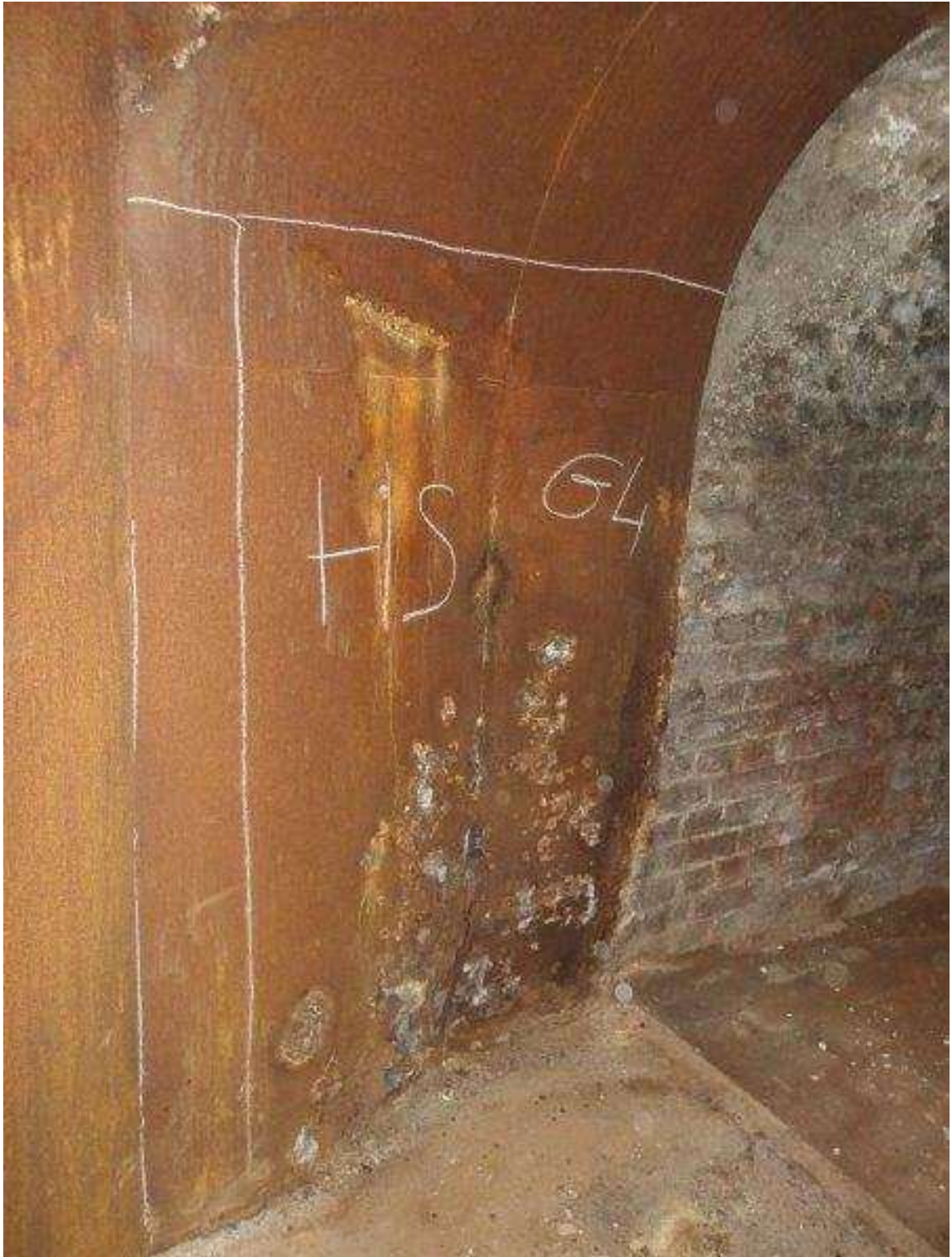
Photo n°258 : Zone à remplacer (1.2mX1.4m + 0.5mX1.4m)
