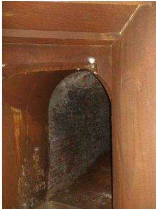
Photo n°259 : Carneau (partie Corten) en bon état.
