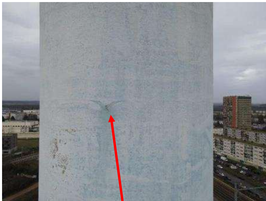
Photo n°35 : Fût béton en bon état, peinture légèrement passée. Armature métallique affleurante.
