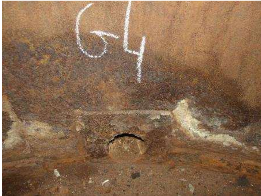
Photo n°220 : Tuyauterie d'évacuation des condensats en bon état
