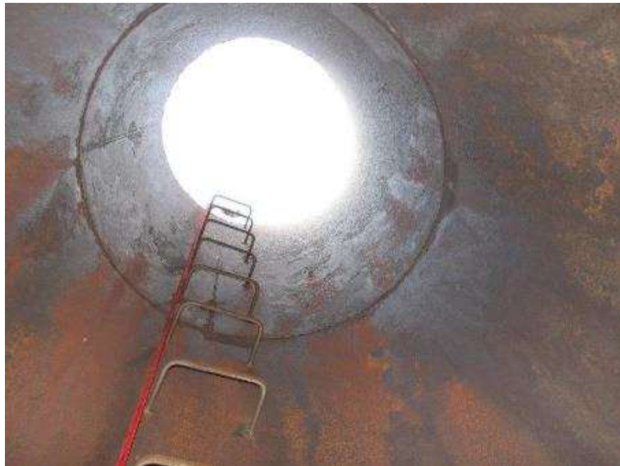
Photo n°141 : Sommet conduit en bon état
