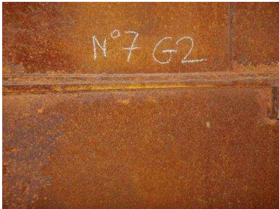
Photo n°173 : Assemblage et conduit en bon état
