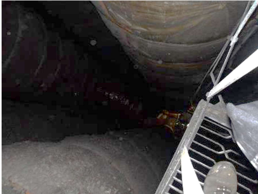
Photo n°97 : Isolation thermique des conduits en bon état
