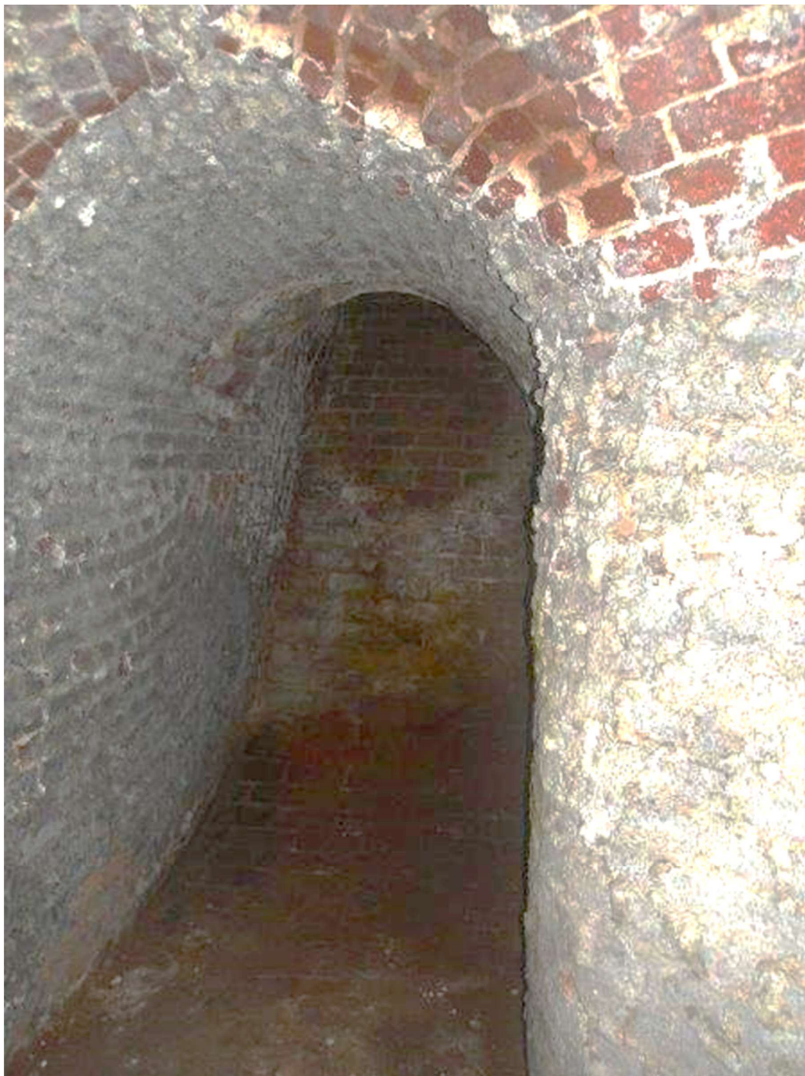
Photo n°263 : Carneau brique en état correct. Remontée vers la chaudière en béton réfractaire (bon état)
