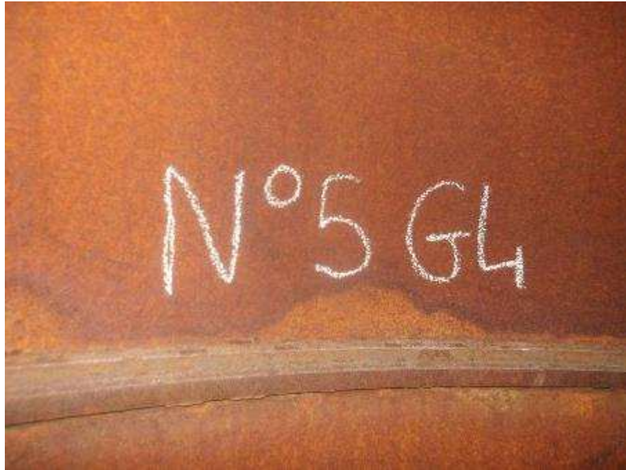
Photo n°230 : Assemblage et conduit en bon état
