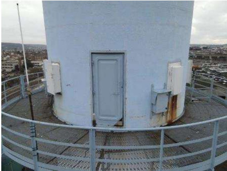
Photo n°65 : Passerelle en bon état, fût béton en bon état, peinture légèrement passée. Coulures venant de la passerelle et des prises de mesures. Porte d'accès depuis l'intérieur en bon état.
