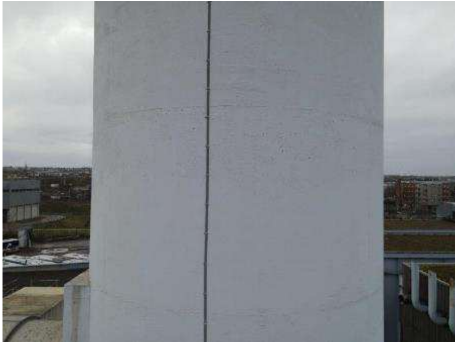
Photo n°21 : Fût béton en bon état, peinture légèrement passée. Conducteur paratonnerre en bon état
