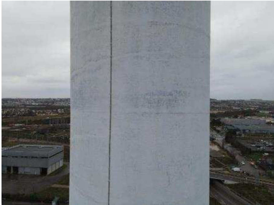
Photo n°13 : Fût béton en bon état, peinture légèrement passée. Conducteur paratonnerre en bon état
