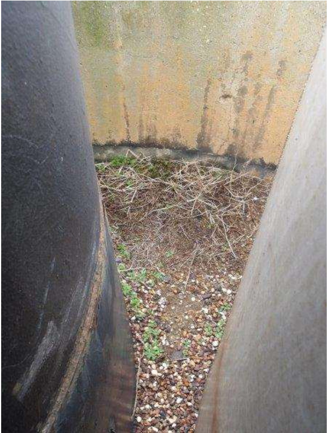
Photo n°77 : Dalle supérieure recouverte de graviers, terre et végétation.
