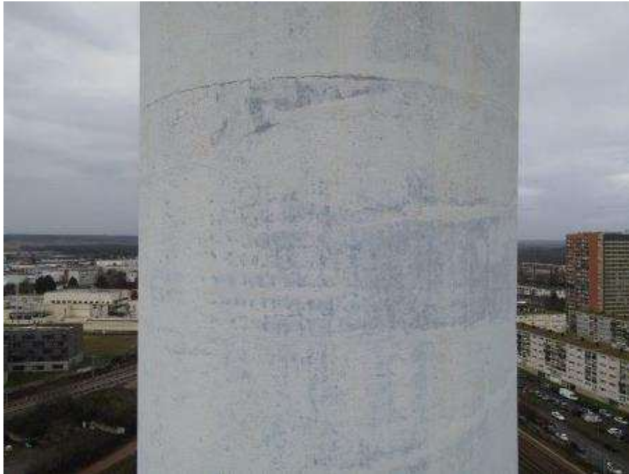
Photo n°37 : Fût béton en bon état, peinture légèrement passée. Conducteur paratonnerre en bon état
