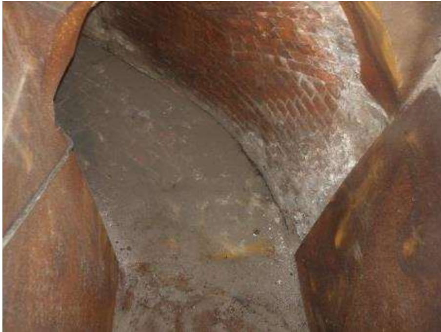
Photo n°148 : Carneau (partie en acier Corten) en bon état Carneau brique en état correct.
