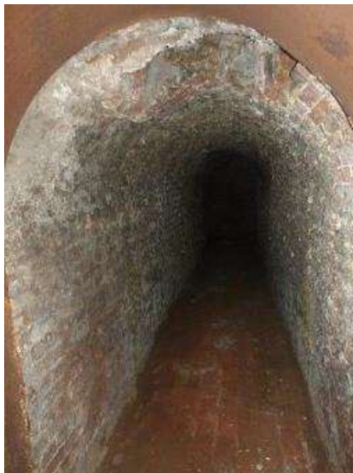
Photo n°260 : Carneau brique en état correct. Sol légèrement gonflé.
