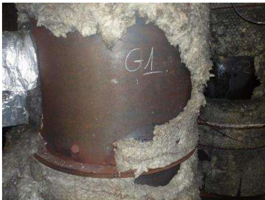
Photo n°102 : Isolant à reprendre (niveau passerelle)
