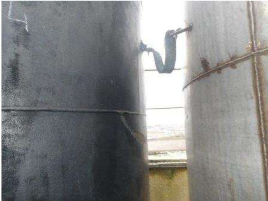
Photo n°83 : Fourreaux de passage des conduit connectés au système de paratonnerre
