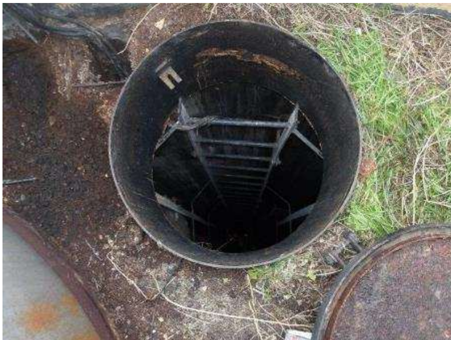
Photo n°76 : Trappe d'accès en bon état
