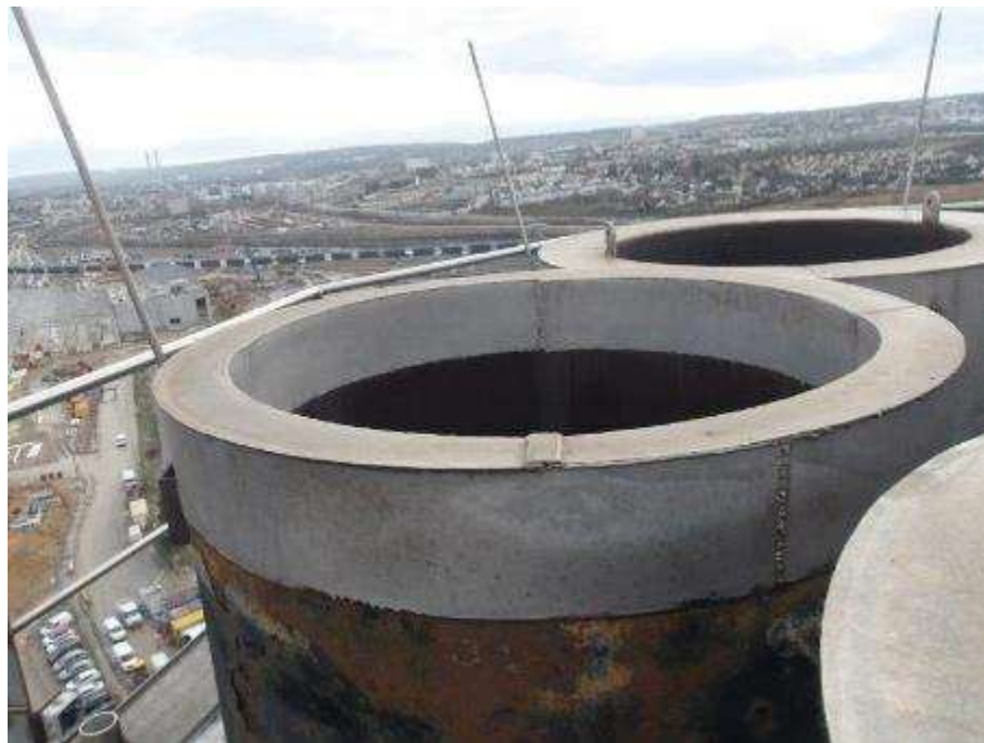
Photo n°195 : Sommet du conduit en Inox sur 200mm en bon état
