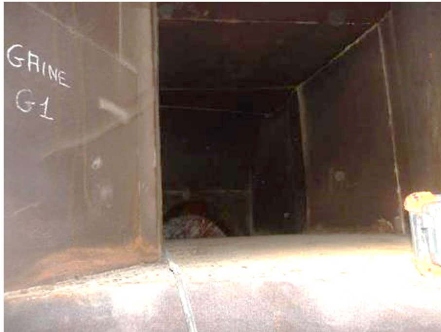
Photo n°146 : Carneau (partie en acier Corten) en bon état
