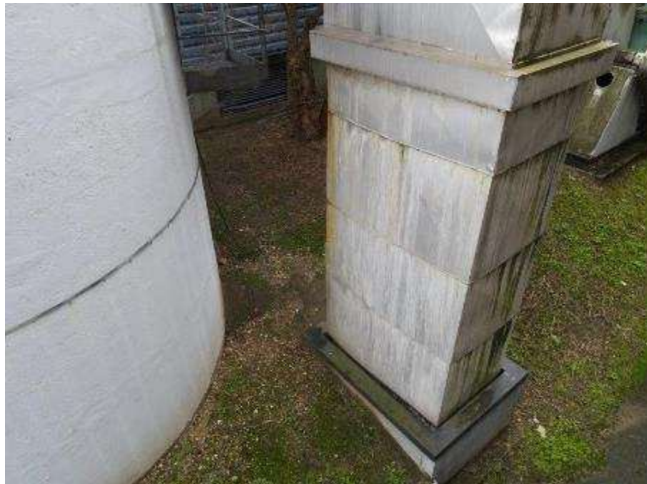
Photo n°58 : Bardage du carneau G3 en bon état
