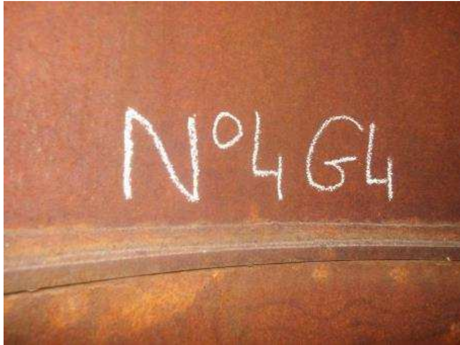
Photo n°228 : Assemblage et conduit en bon état
