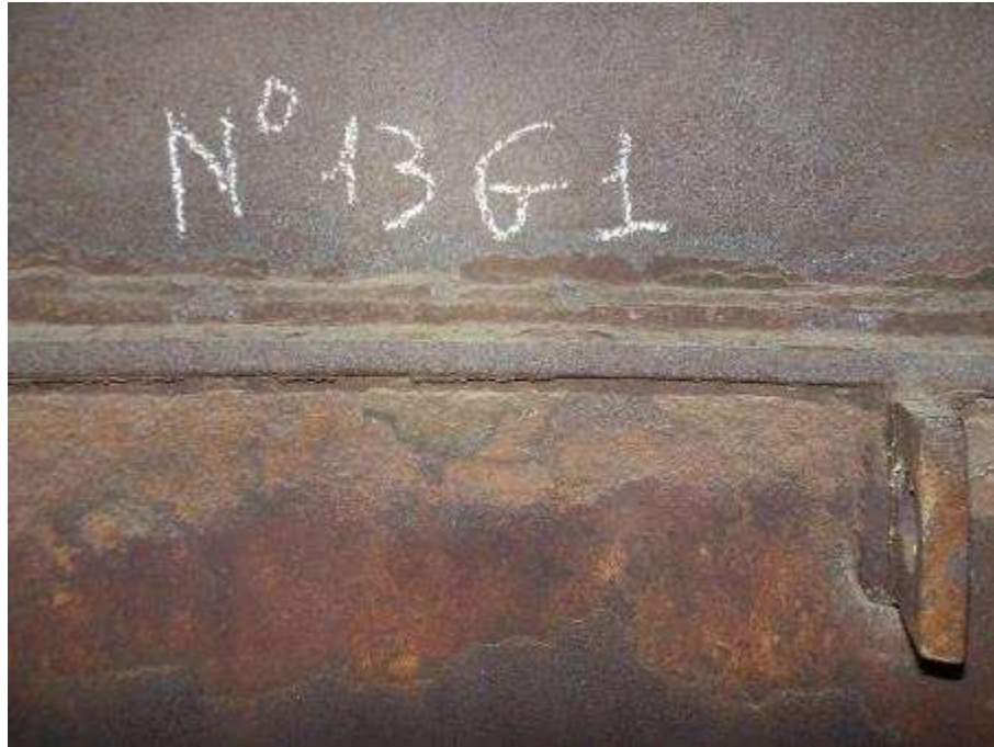
Photo n°136 : Assemblage et conduit en bon état
