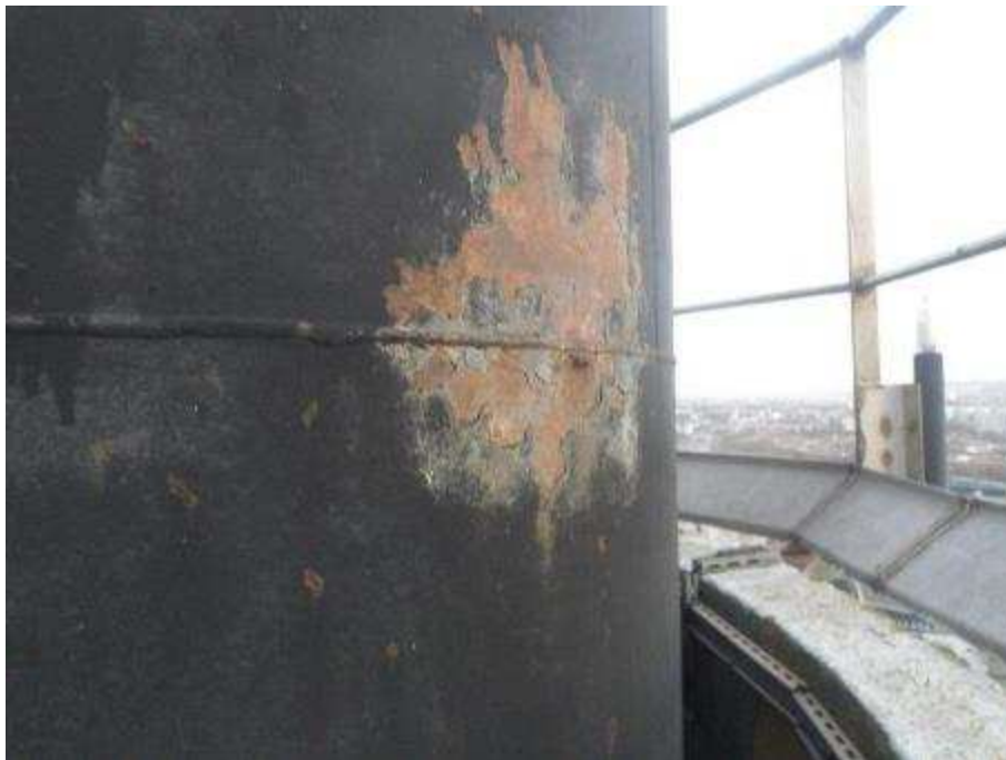
Photo n°255 : Fourreau de passage du conduit oxydé.
