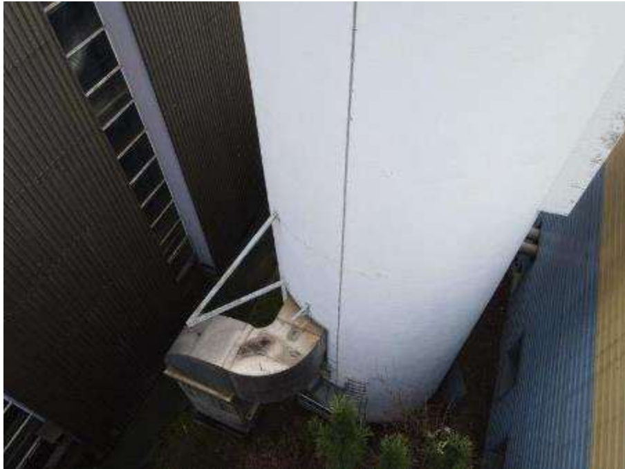
Photo n°53 : Fût béton en bon état, peinture légèrement passée. Conducteur paratonnerre en bon état
