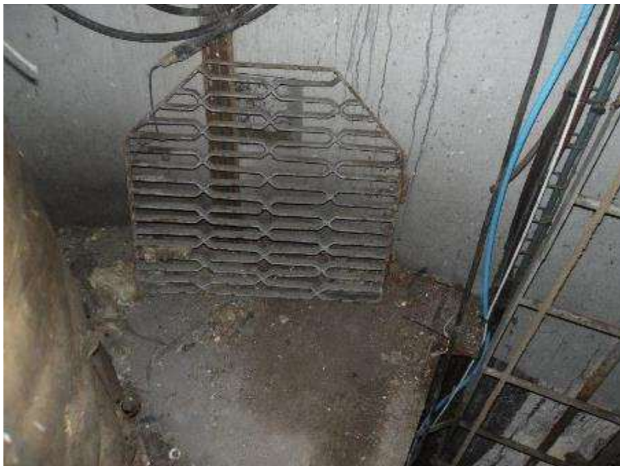
Photo n°110 : Trappe caillebotis donnant accès à 0m (base des conduits) à reprendre.
