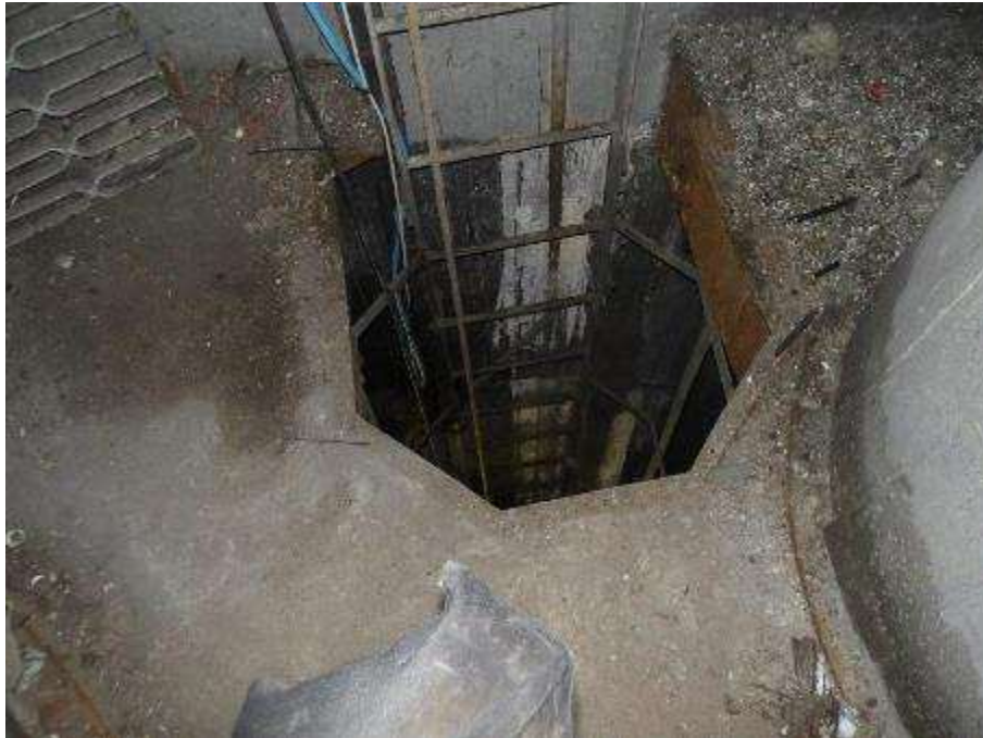
Photo n°109 : Trappe caillebotis donnant accès à 0m (base des conduits) à reprendre.
