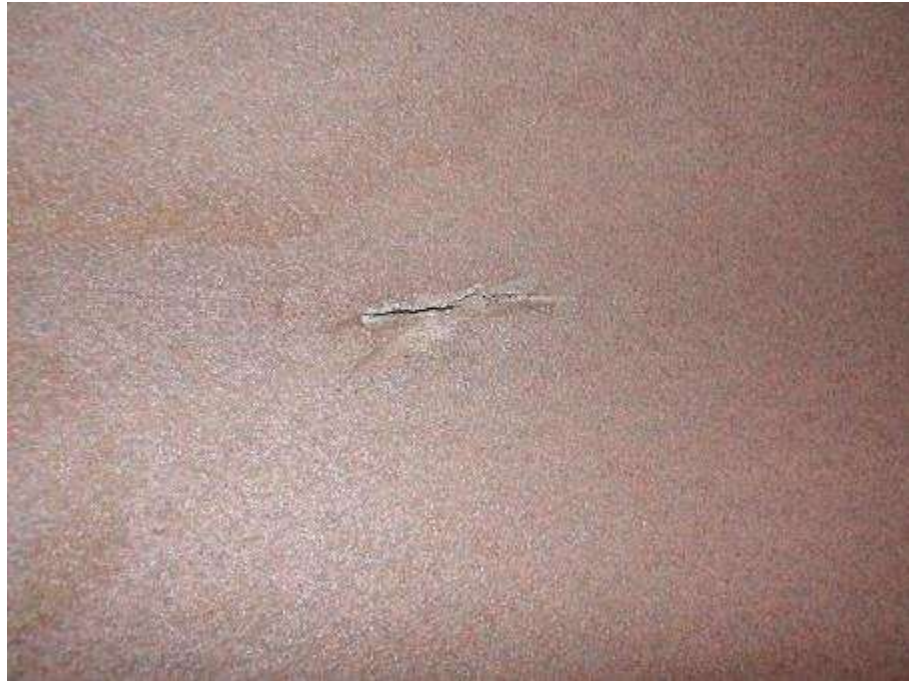
Photo n°190 : Fissure en partie supérieure du conduit sur environ 100mm
