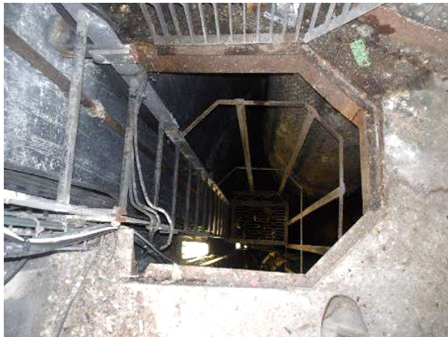
Photo n°106 : Trappe caillebotis en bon état.
