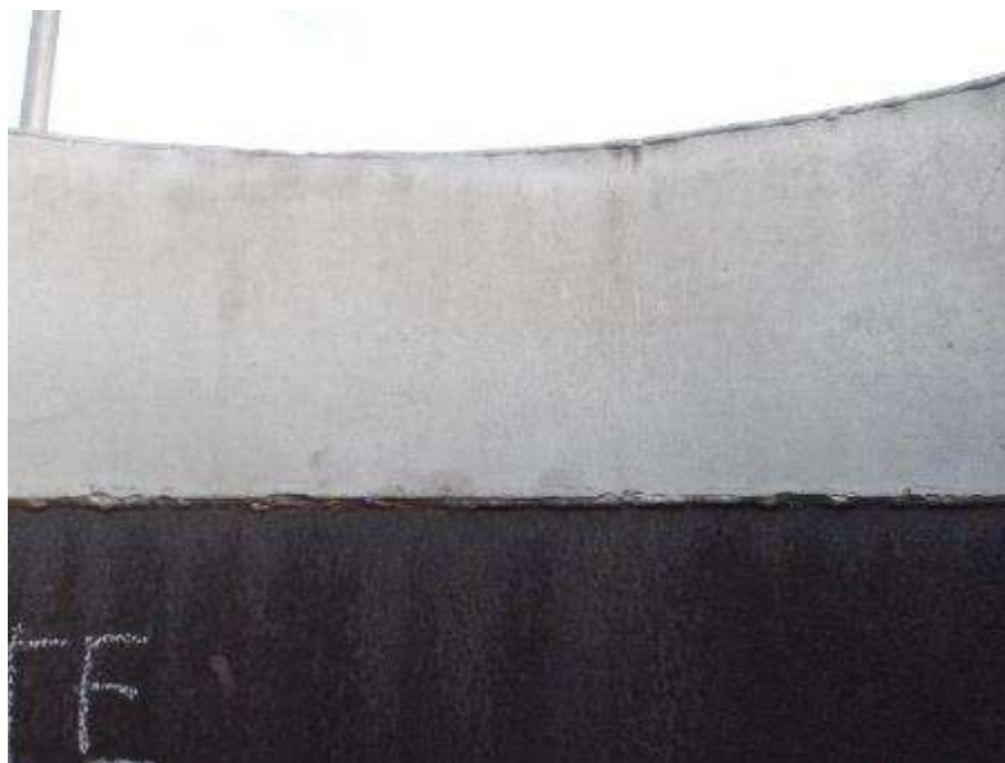
Photo n°192 : Bandeau Inox sur 200mm au sommet du conduit en bon état
