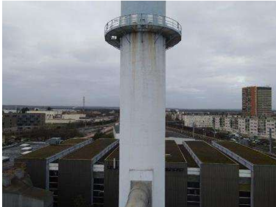
Photo n°25 : Fût béton en bon état, peinture légèrement passée. Coulures venant de la passerelle et des prises de mesures.
