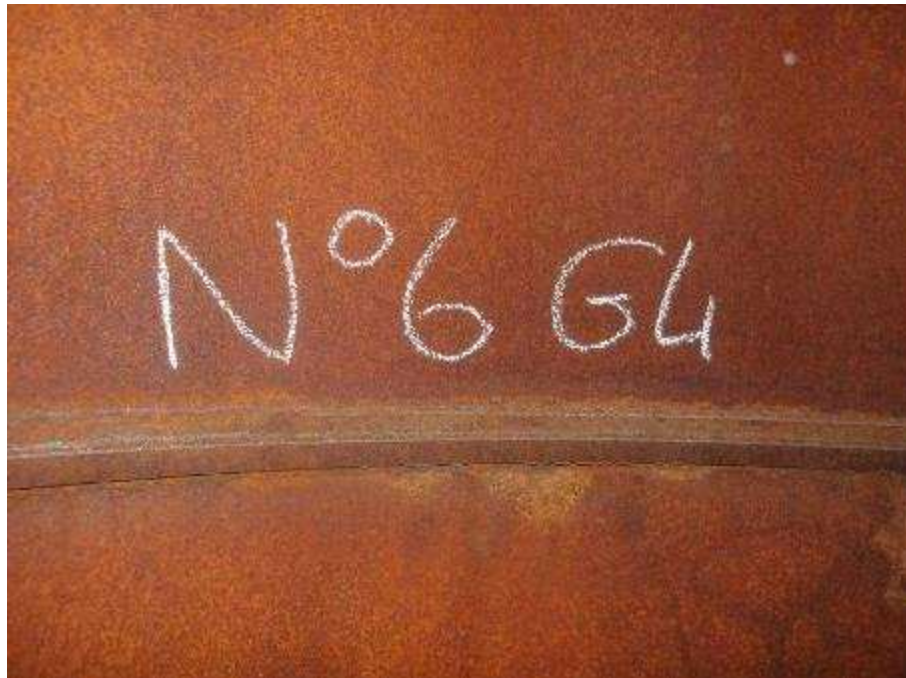
Photo n°231 : Assemblage et conduit en bon état
