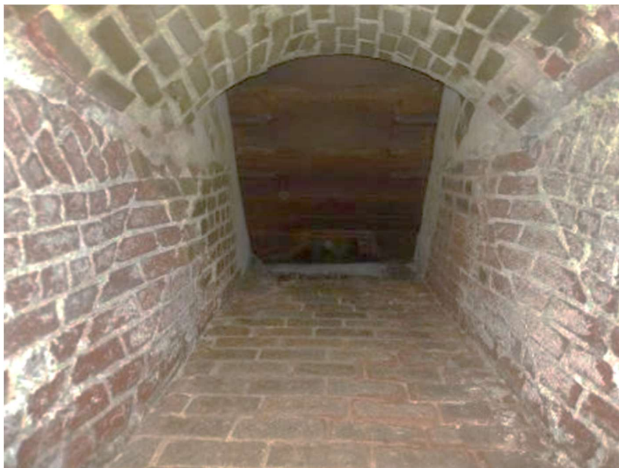
Photo n° : 264 Carneau brique en état correct. Remontée vers la chaudière en béton réfractaire (bon état)
