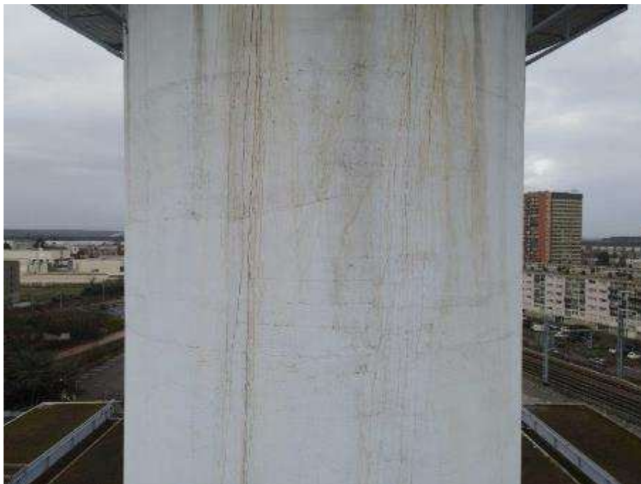
Photo n°28 : Fût béton en bon état, peinture légèrement passée. Coulures venant de la passerelle et des prises de mesures.
