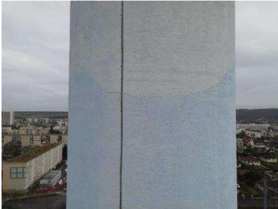
Photo n°43 : Fût béton en bon état, peinture légèrement passée. Conducteur paratonnerre en bon état
