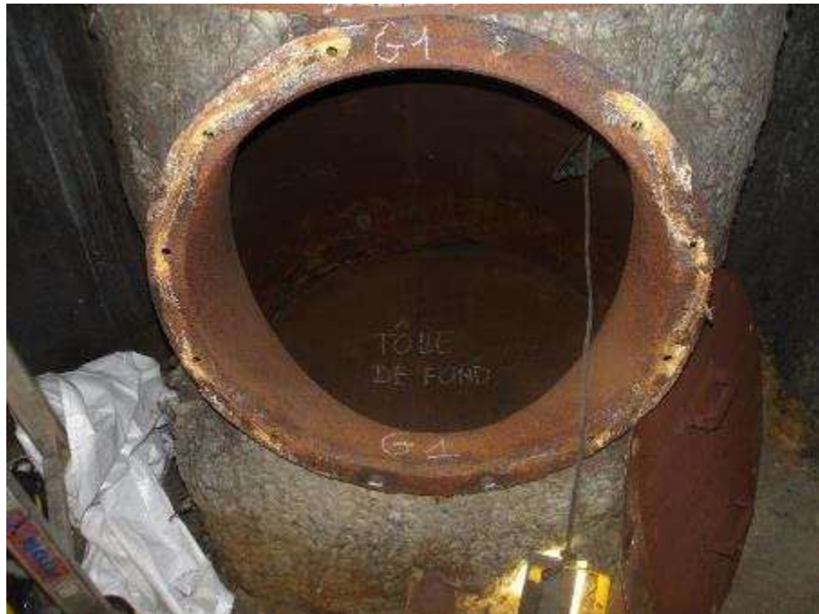
Photo n°113 : Trappe de visite en bon état
