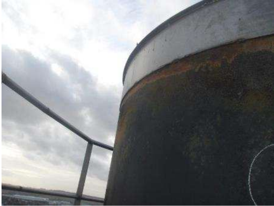
Photo n°252 : Fourreau de passage du conduit oxydé.
