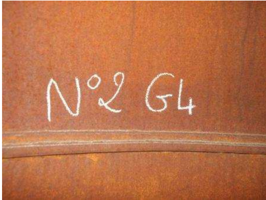
Photo n°224 : Assemblage et conduit en bon état
