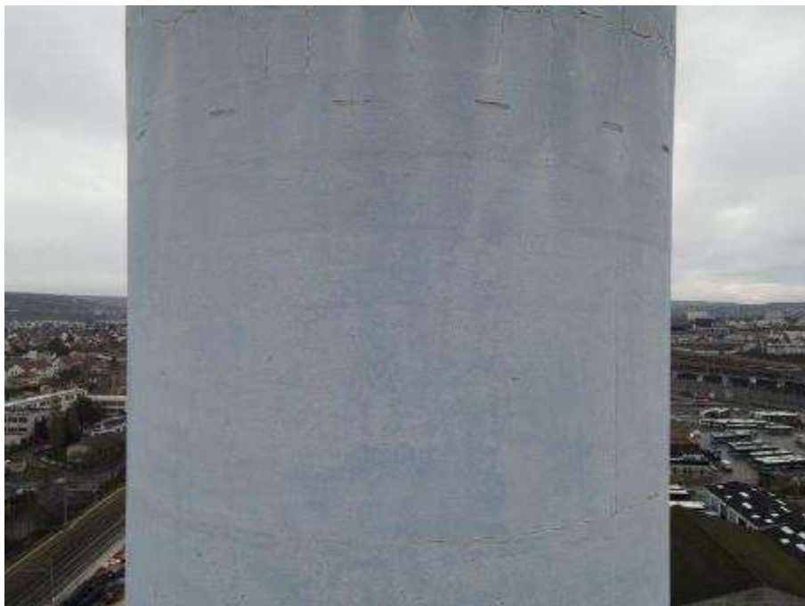
Photo n°70 : Fût béton en bon état, peinture légèrement passée.
