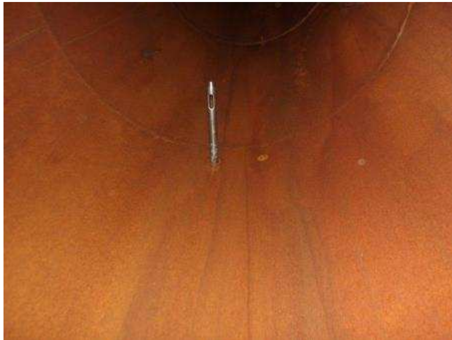
Photo n°225 : Sonde en bon état
