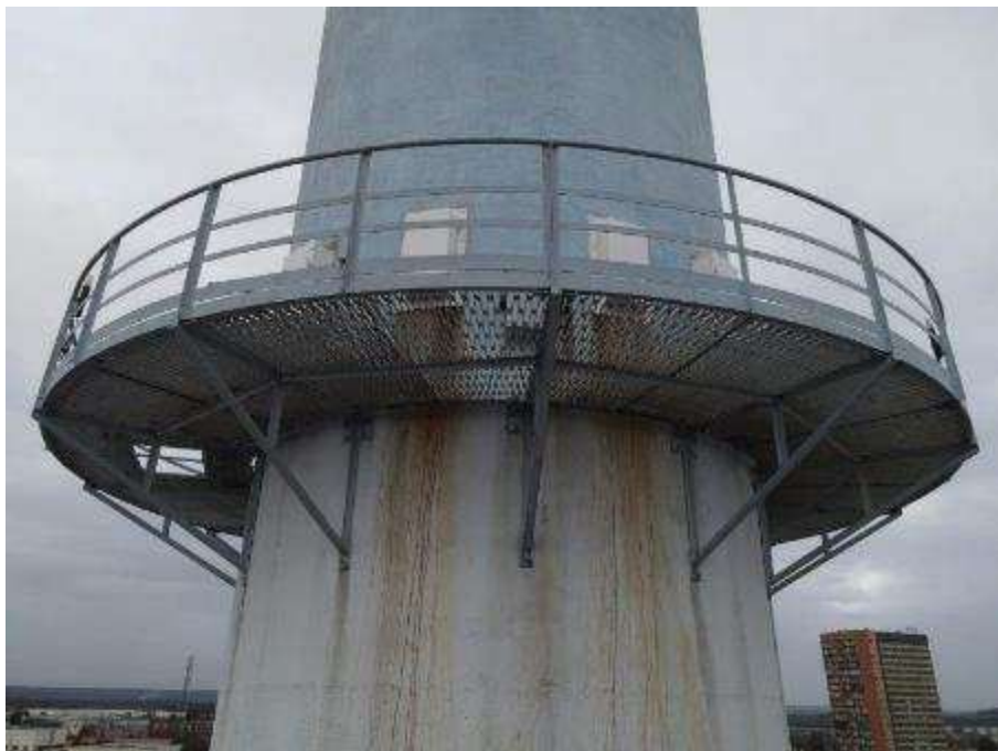
Photo n°30 : Passerelle en bon état, fût béton en bon état, peinture légèrement passée. Coulures venant de la passerelle et des prises de mesures.
