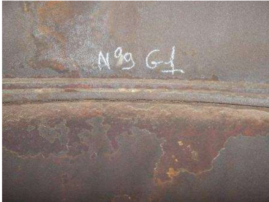
Photo n°128 : Assemblage et conduit en bon état
