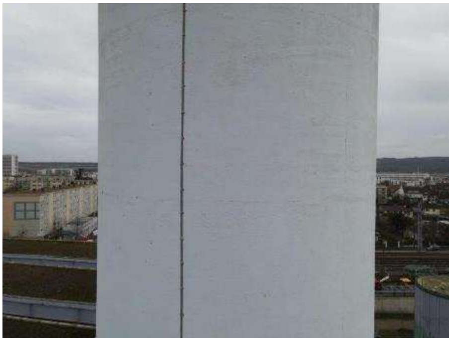
Photo n°50 : Fût béton en bon état, peinture légèrement passée. Conducteur paratonnerre en bon état
