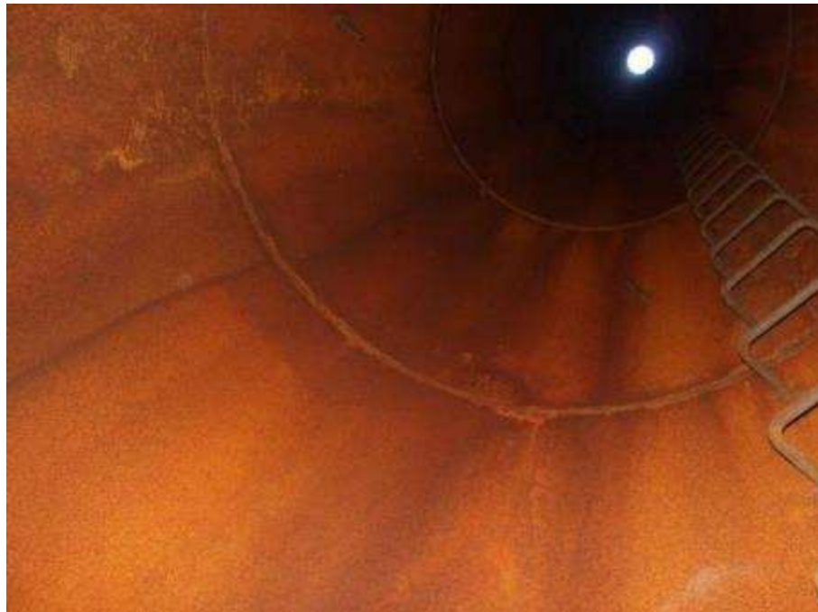
Photo n°229 : Conduit en bon état
