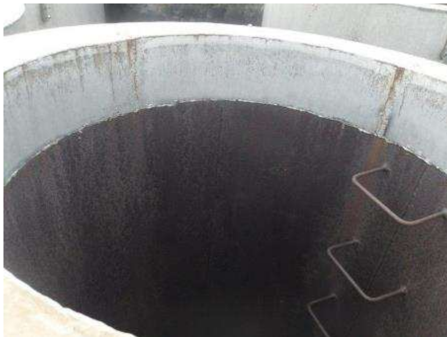
Photo n°196 : Sommet du conduit en Inox sur 200mm en bon état
