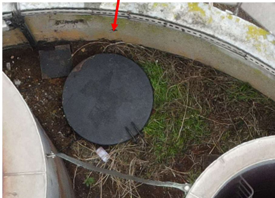
Photo n°74 : Dalle supérieure recouverte de graviers, terre et végétation. Trappe d'accès en bon état.
