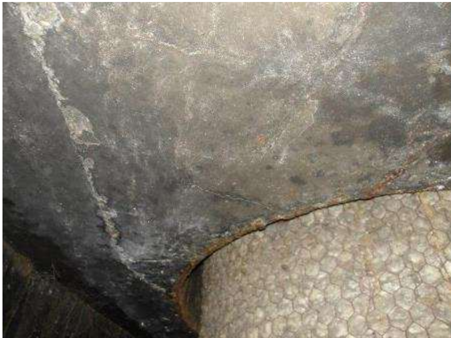
Photo n°88 : Face inférieure de la dalle béton sommitale en bon état sur une majorité de sa surface.
