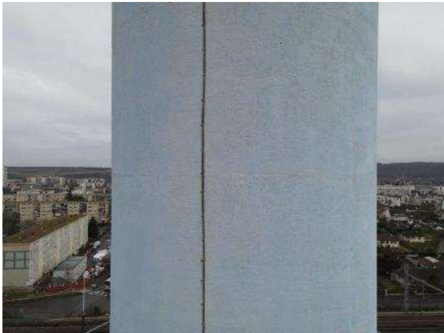
Photo n°44 : Fût béton en bon état, peinture légèrement passée. Conducteur paratonnerre en bon état
