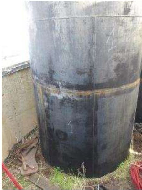
Photo n°144 : Fourreau de passage du conduit oxydé (à repeindre)
