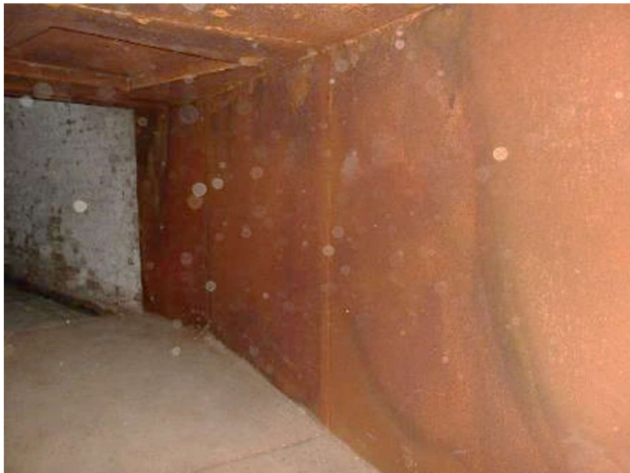
Photo n°201 : Carneau (partie en acier Corten) en bon état
