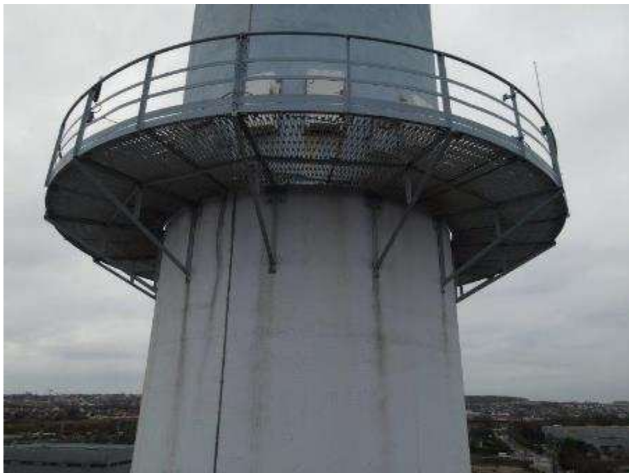
Photo n°18 : Passerelle en bon état, quelques coulures sur la peinture.
