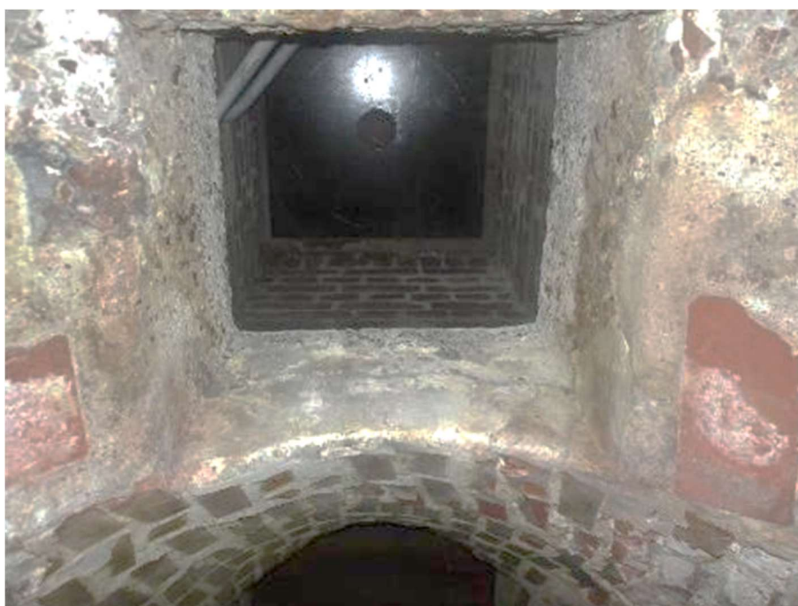
Photo n°265 : Trappe d'accès vers la chaufferie
