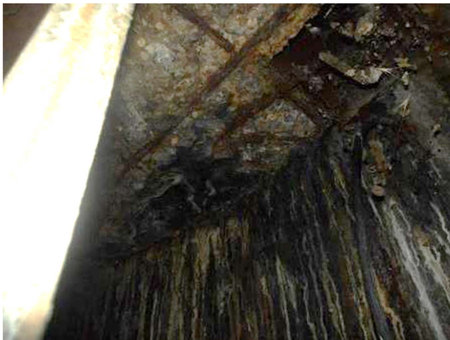
Photo n°89 : Face inférieure de la dalle béton sommitale en mauvais état sur 1/4 de sa surface.
