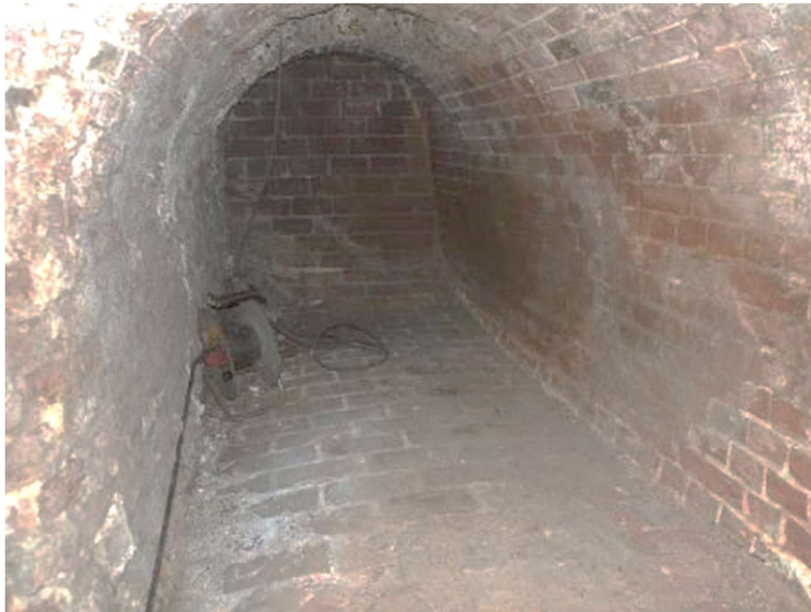
Photo n°152 : Carneau brique en état correct. Léger gonflement du sol.
