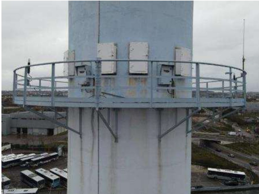
Photo n°17 : Passerelle en bon état, capotages des prises de mesures en bon état.
