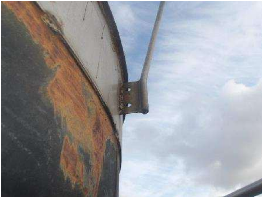
Photo n°254 : Fourreau de passage du conduit oxydé. Ponte de paratonnerre en bon état
