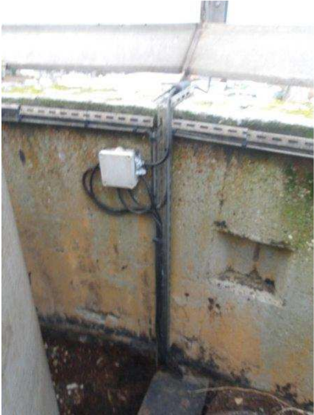
Photo n°80 : Alimentation électrique des lampes de balisage en bon état.
