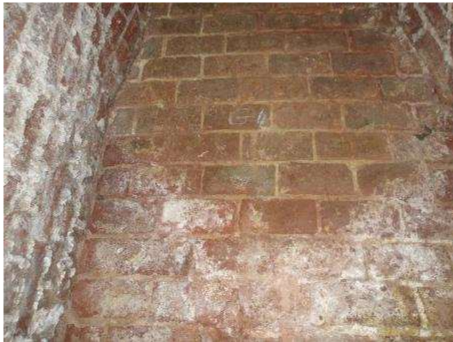
Photo n°262 : Carneau brique en état correct. Remontée vers la chaudière en béton réfractaire (bon état)
