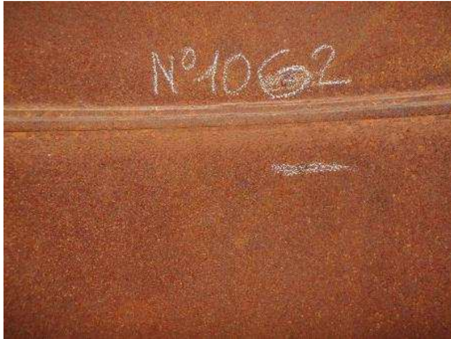
Photo n°176 : Assemblage et conduit en bon état
