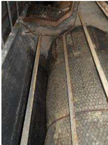
Photo n°108 : Echelle à crinoline en bon état
