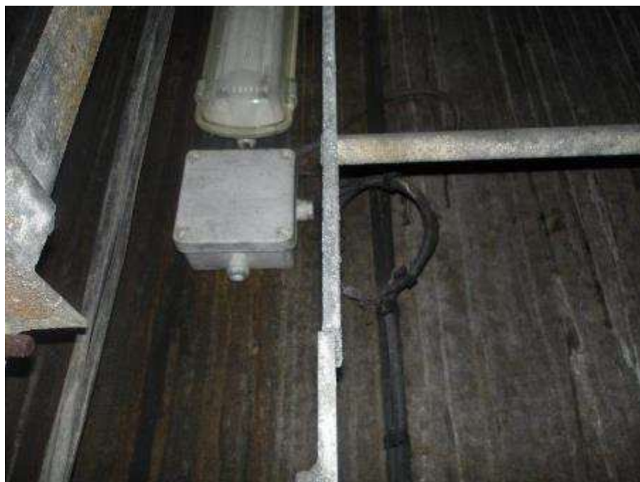
Photo n°96 : Système d'éclairage H.S. de la passerelle jusqu'au sommet
