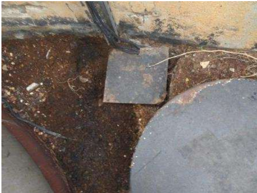
Photo n°78 : Passage de câble (lampes de balisage) non étanche
