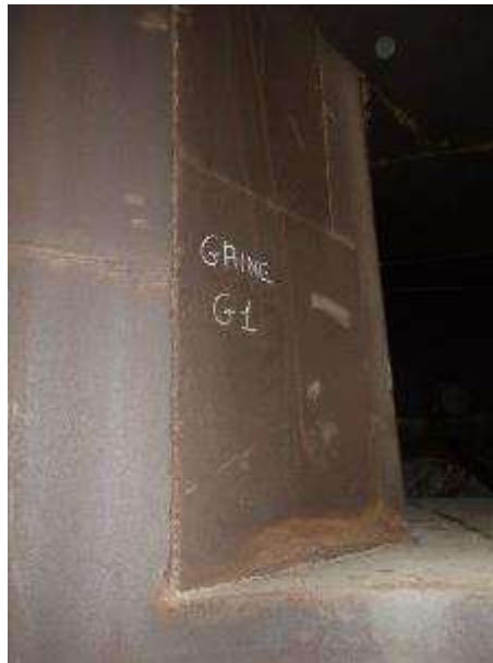
Photo n°115 : Piquage d'entrée des fumées en bon état
