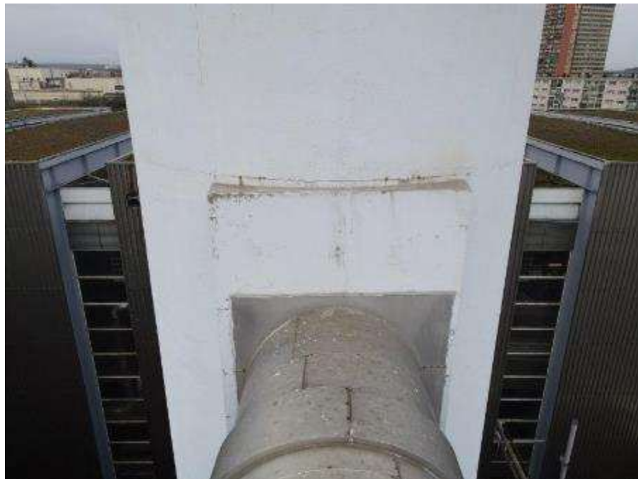
Photo n°26 : Fût béton en bon état, peinture légèrement passée.
