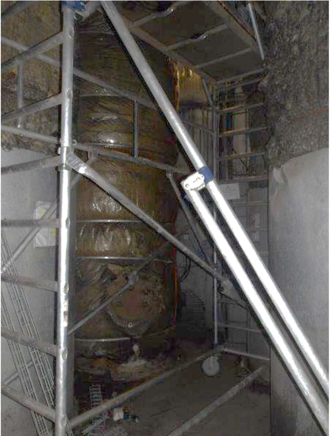
Photo n°111 : Isolation des conduits en bon état.
