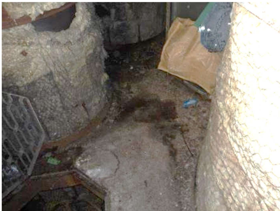
Photo n°104 : Plancher béton niveau passerelle en bon état.
