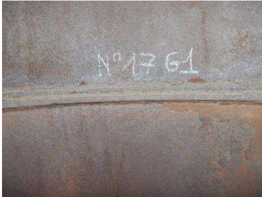
Photo n°140 : Assemblage et conduit en bon état
