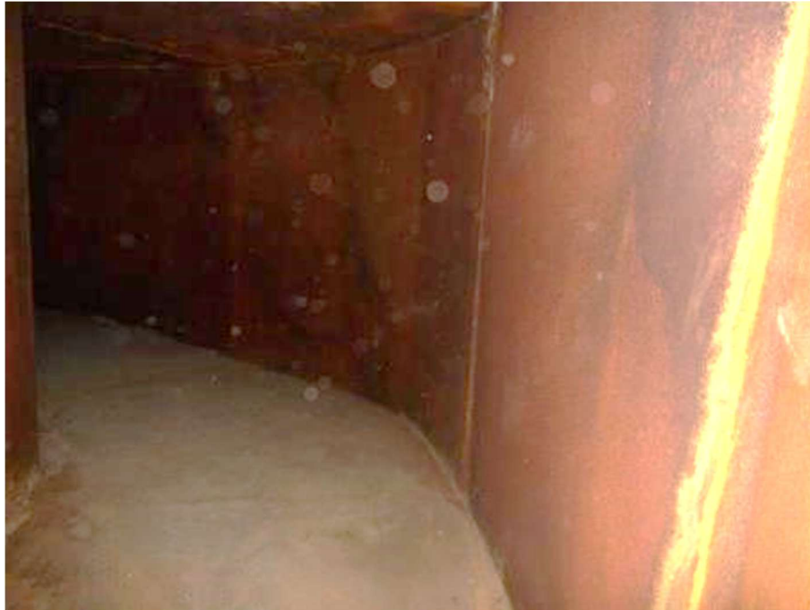
Photo n°200 : Carneau (partie en acier Corten) en bon état
