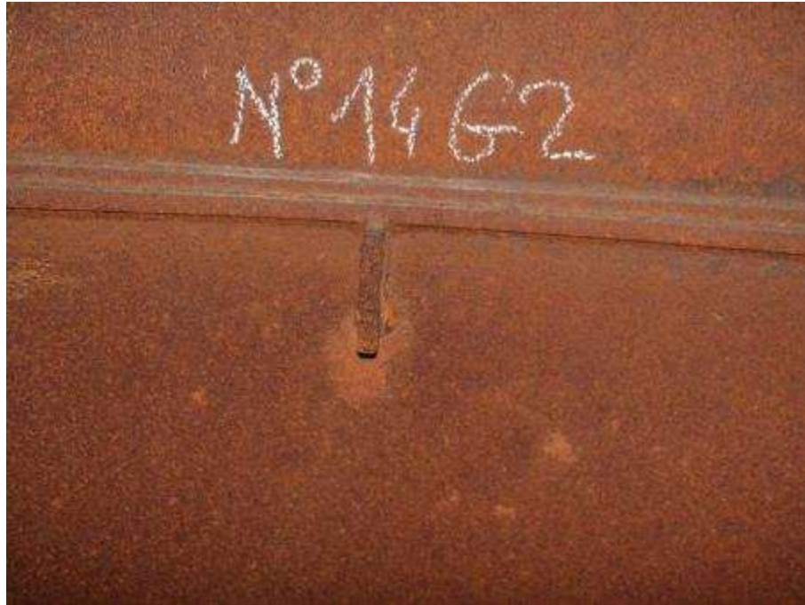
Photo n°184 : Assemblage et conduit en bon état
