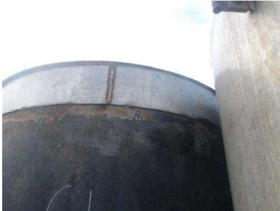
Photo n°250 : Fourreau de passage du conduit oxydé.
