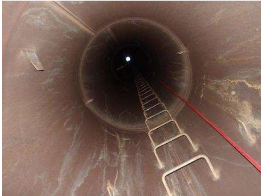
Photo n°118 : Conduit en bon état
