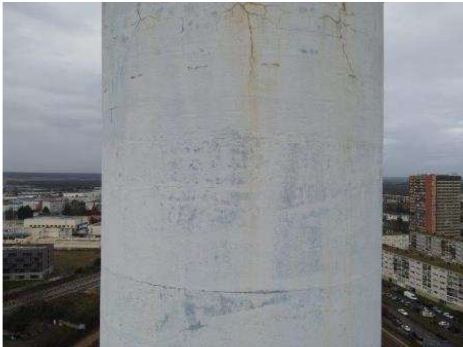
Photo n°38 : Fissuration multiple en partie haute, peinture légèrement passée.
