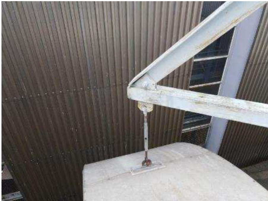
Photo n°56 : Console support de carneau G3 en bon état
