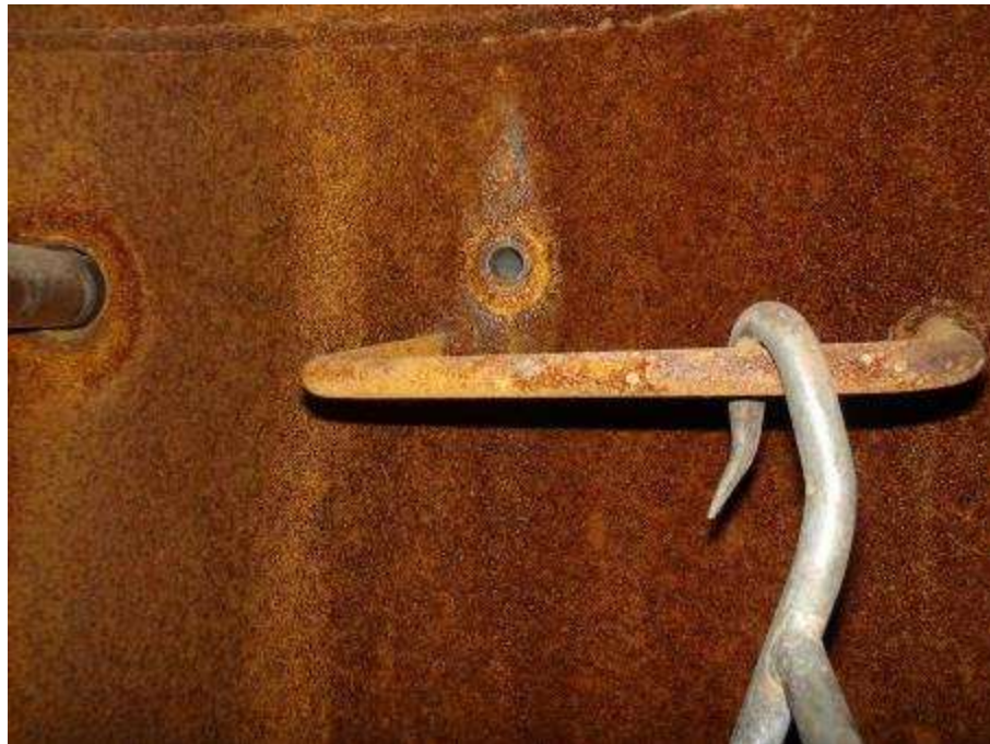
Photo n°167 : Conduit en bon état
