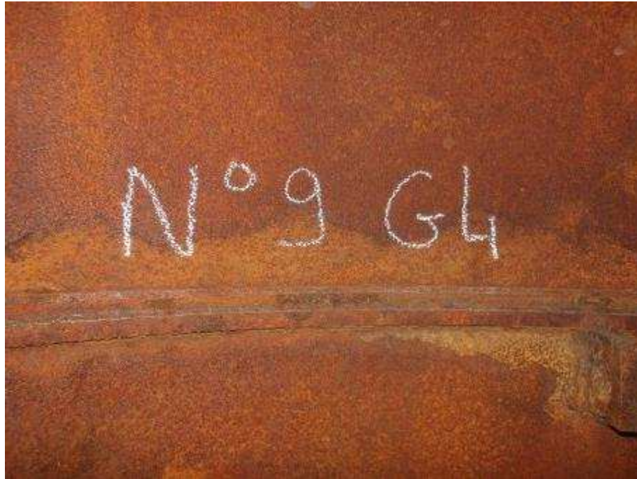
Photo n°234 : Assemblage et conduit en bon état
