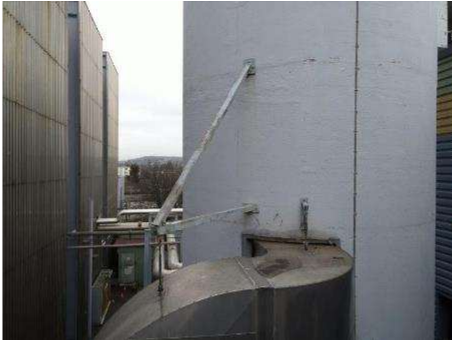
Photo n°55 : Console support de carneau G3 en bon état
