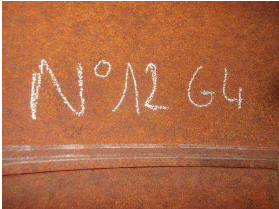
Photo n°241 : Assemblage et conduit en bon état
