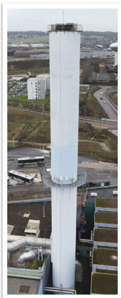
Cheminée Béton 63m
