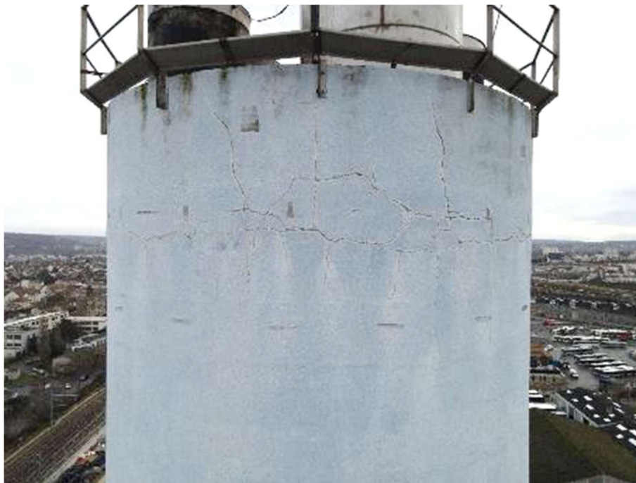
Photo n°7 : Fissuration importante du béton (ancienne réparation)
