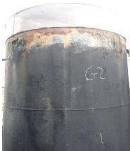
Photo n°197 : Fourreau de passage du conduit oxydé (à repeindre)
