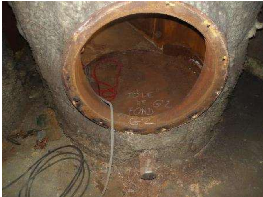
Photo n°157 : Trappe de visite en bon état
