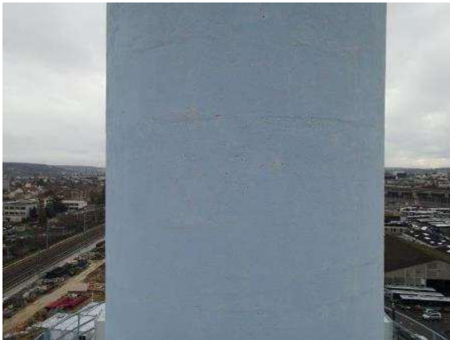
Photo n°66 : Fût béton en bon état, peinture légèrement passée.
