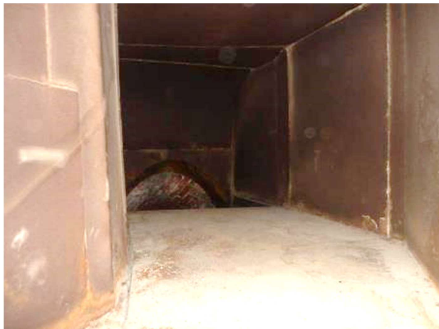
Photo n°147 : Carneau (partie en acier Corten) en bon état
