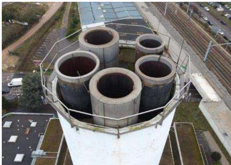
Photo n°72 : Garde-corps, pointes de paratonnerre et lampes de balisage en bon état.
