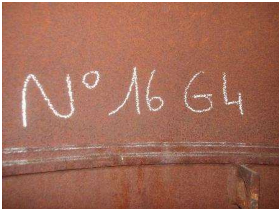
Photo n°245 : Assemblage et conduit en bon état
