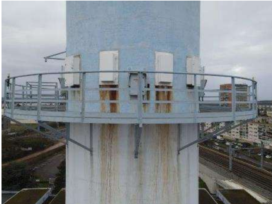
Photo n°31 : Passerelle en bon état, fût béton en bon état, peinture légèrement passée. Coulures venant de la passerelle et des prises de mesures.
