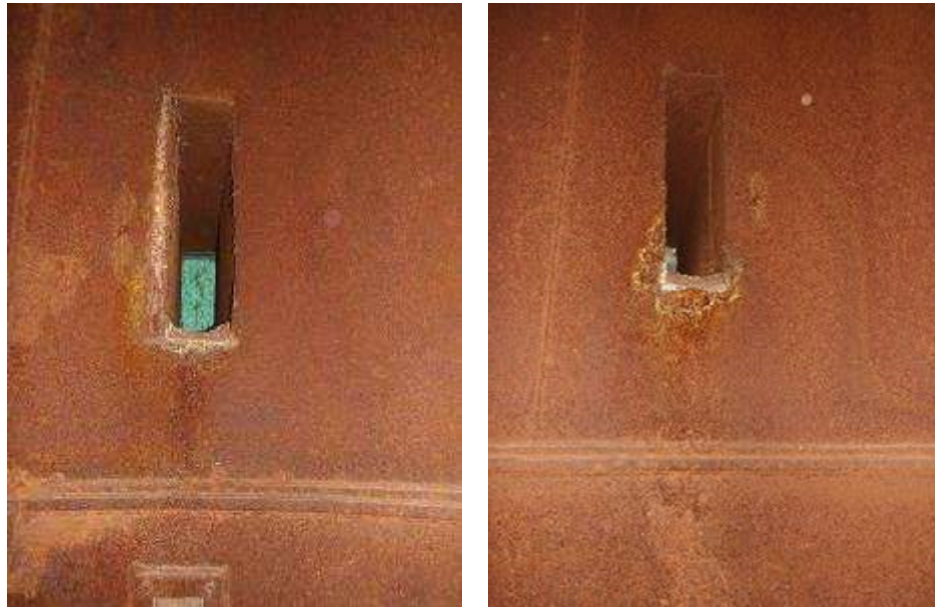
Photo n°177 : Prises de mesures NFX en bon état
