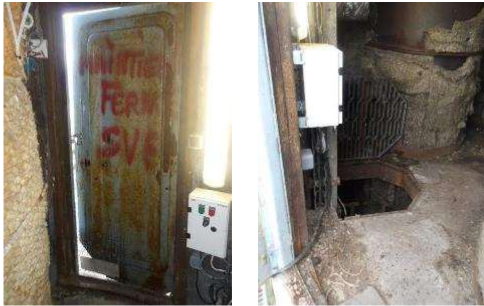
Photo n°105 : Porte d'accès à la passerelle et trappe caillebotis en bon état
