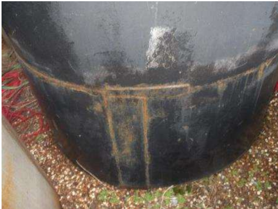
Photo n°253 : Fourreau de passage du conduit oxydé.
