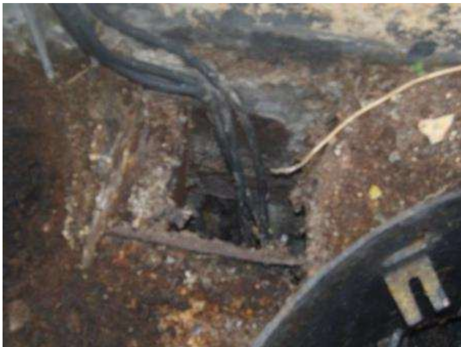
Photo n°79 : Passage de câble (lampes de balisage) non étanche.
