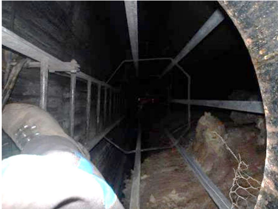
Photo n°87 : Echelle à crinoline interne en bon état
