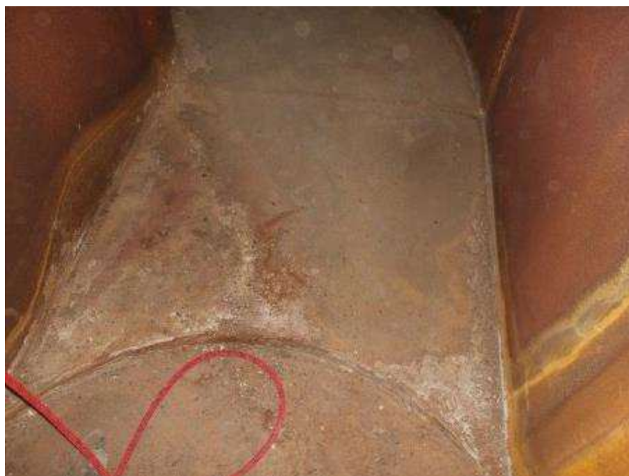
Photo n°159 : Carneau (partie en acier Corten) en bon état.
