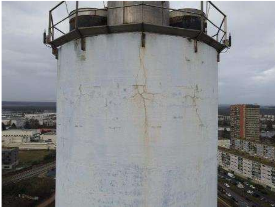
Photo n°39 : Fissuration multiple en partie haute.
