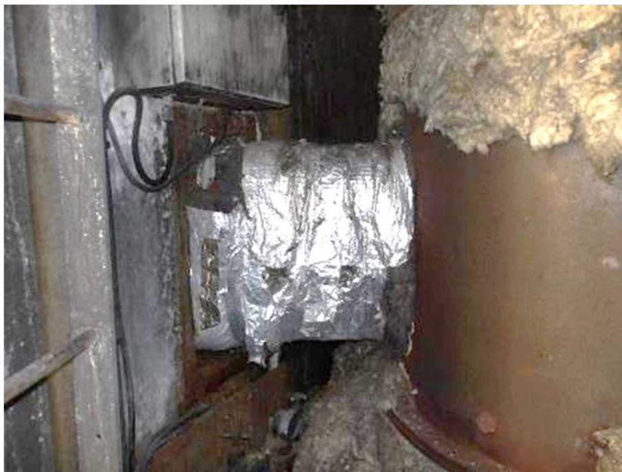
Photo n°103 : Isolant à reprendre (niveau passerelle)
