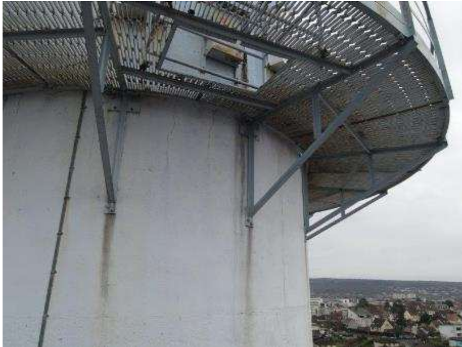
Photo n°49 : Fût béton en bon état, peinture légèrement passée. Coulures venant de la passerelle et des prises de mesures.
