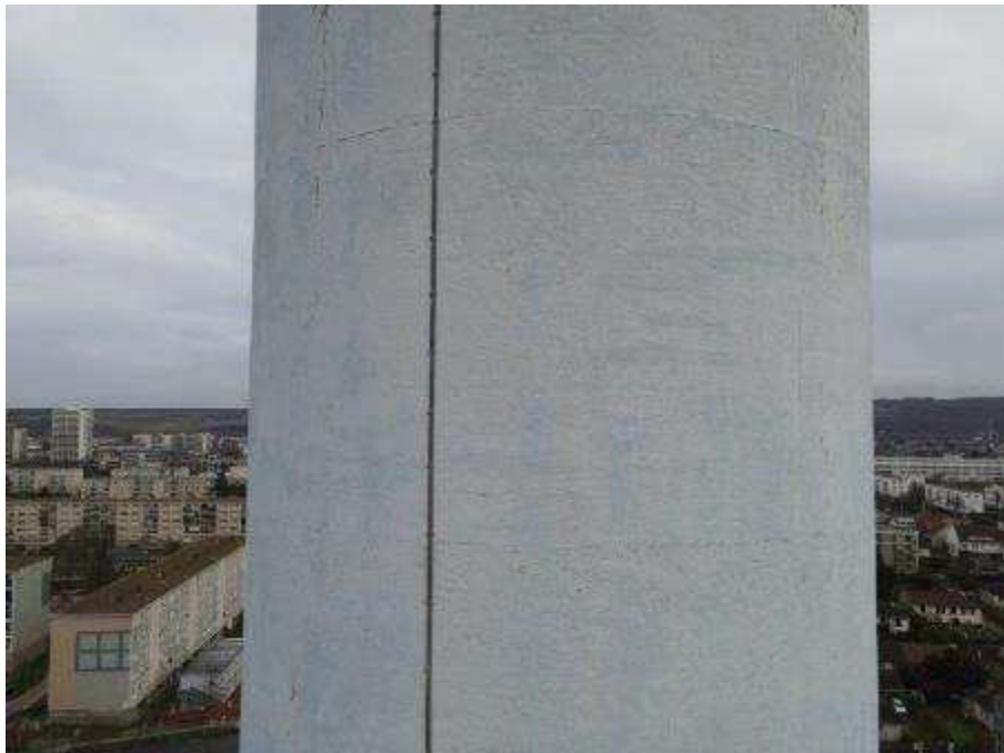
Photo n°42 : Fût béton en bon état, peinture légèrement passée. Conducteur paratonnerre en bon état
