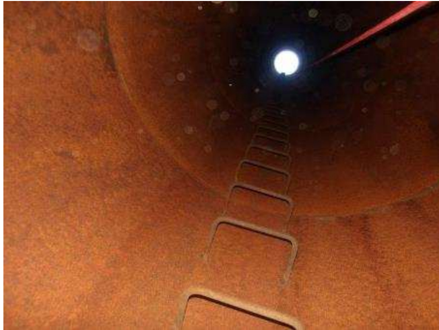
Photo n°240 : Conduit en bon état
