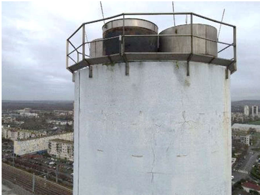
Photo n°5 : Fissuration importante du béton sur environ 1.5m de hauteur et sur 360
