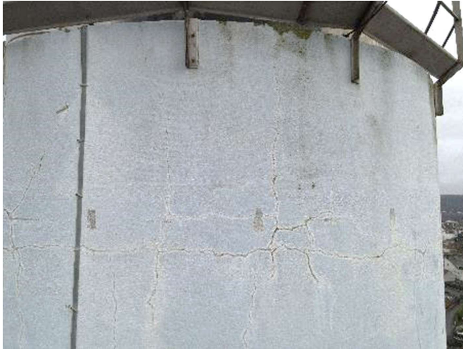
Photo n°6 : Fissuration importante du béton (ancienne réparation)
