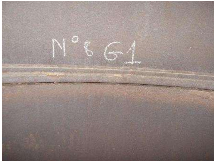
Photo n°127 : Assemblage et conduit en bon état
