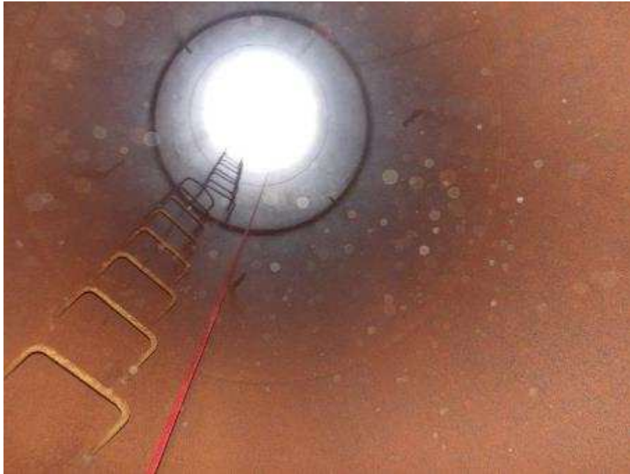
Photo n°188 : Conduit en bon état
