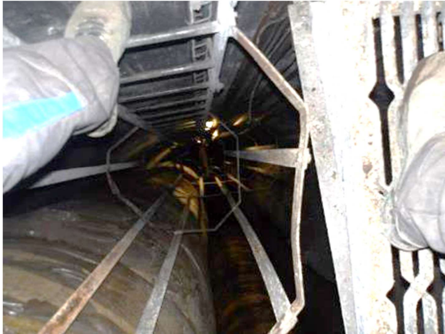
Photo n°107 : Echelle à crinoline en bon état
