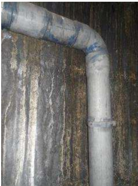
Photo n°92 : Tuyauterie d'évacuation des eaux pluviales en bon état.
