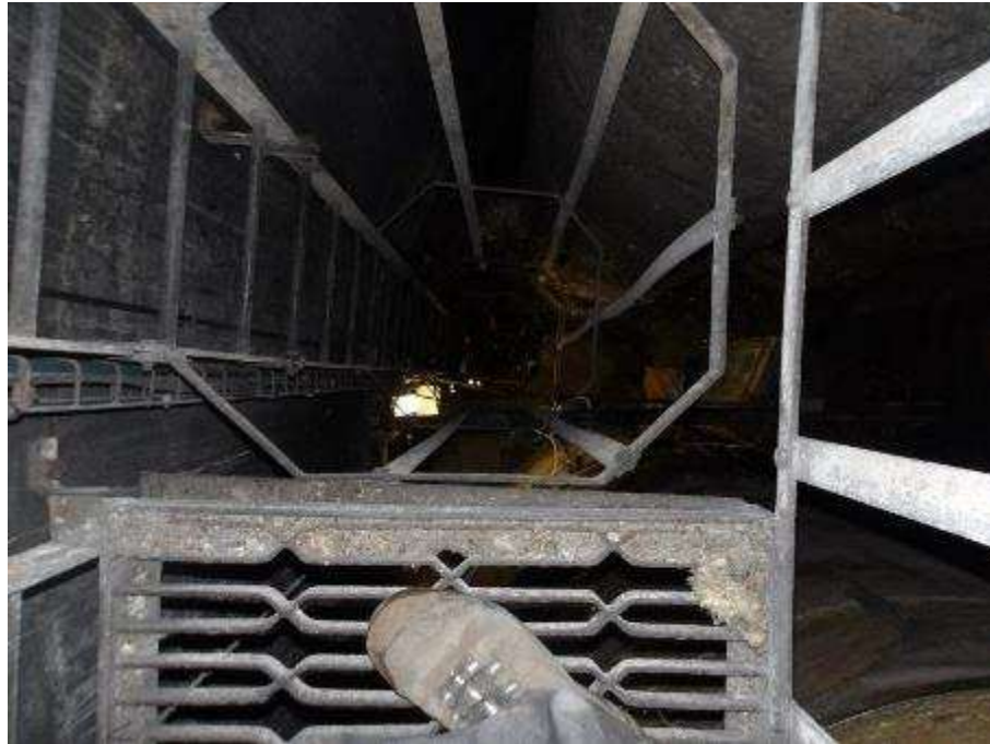
Photo n°99 : Echelle à crinoline en bon état
