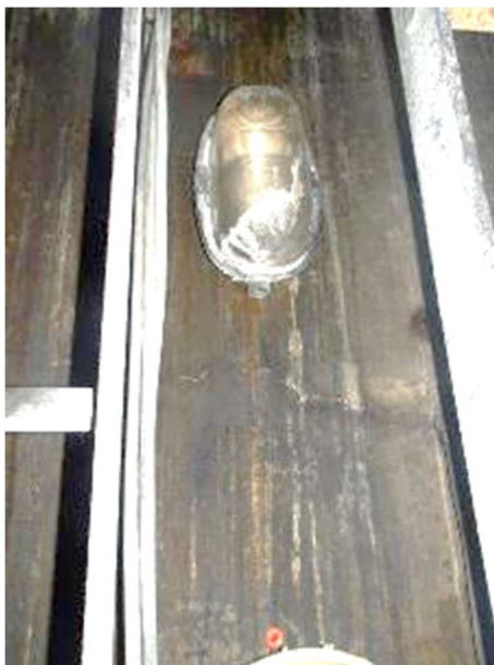
Photo n°95 : Système d'éclairage H.S. de la passerelle jusqu'au sommet
