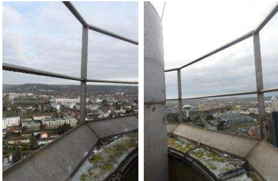
Photo n°82 : Garde-corps Inox en bon état
