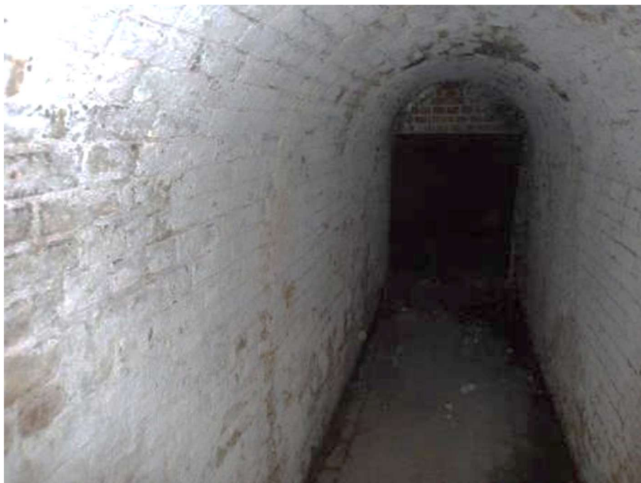
Photo n°213 : Carneau brique en état correct. Remontée vers la chaudière en béton réfractaire (bon état)
