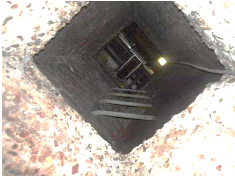
Photo n°154 : Trappe d'accès du carneau vers chaufferie
