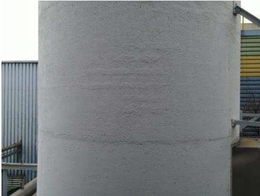
Photo n°59 : Fut béton en bon état.
