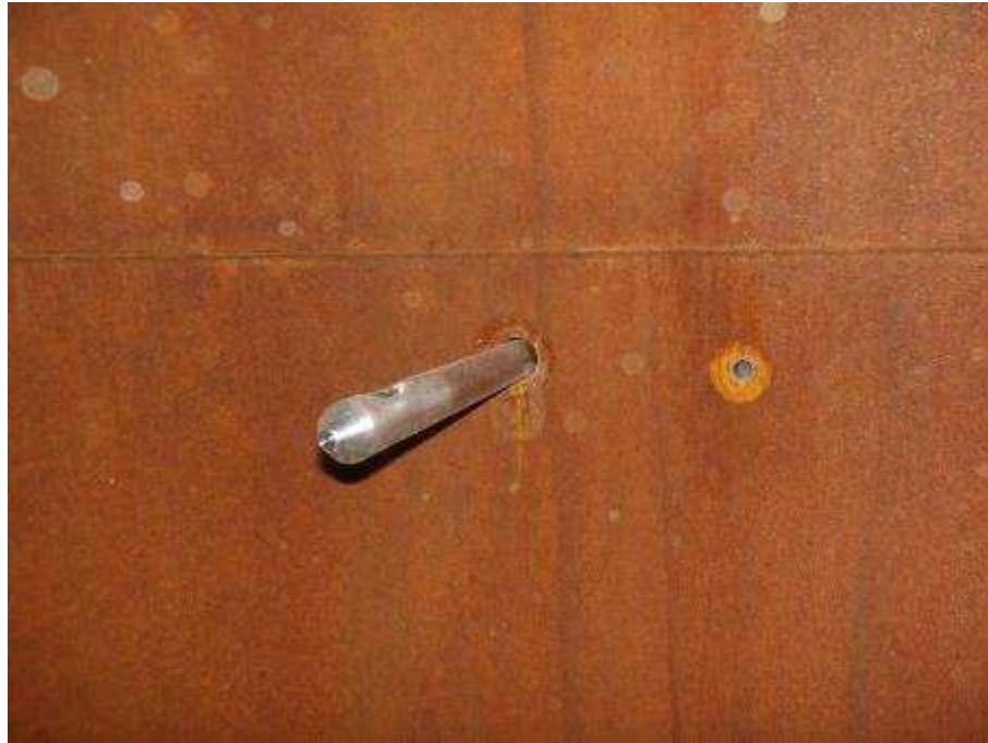
Photo n°226 : Sonde en bon état
