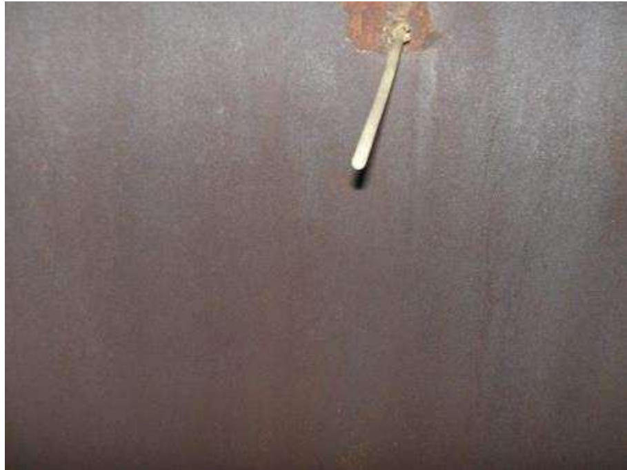
Photo n°132 : Sonde température en bon état
