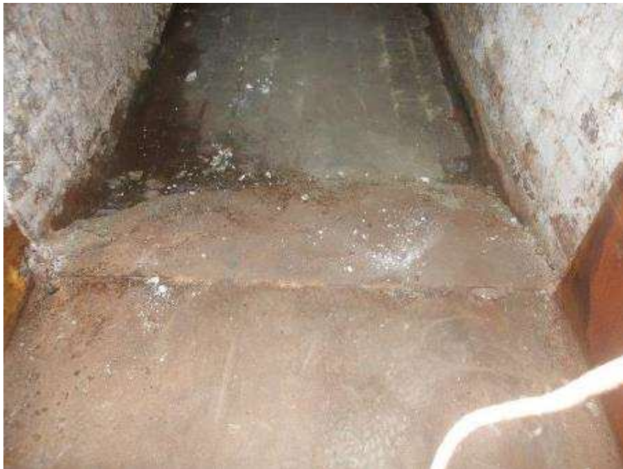
Photo n°203 : Carneau brique en état correct. Léger gonflement du sol.
