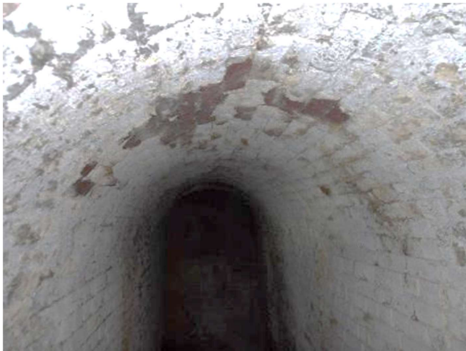
Photo n°209 : Carneau brique en état correct. Léger gonflement du sol.
