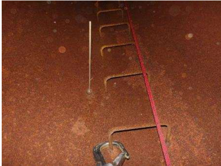
Photo n°186 : Sonde en bon état
