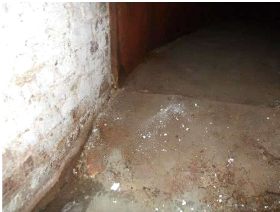
Photo n°206 : Carneau brique en état correct.
