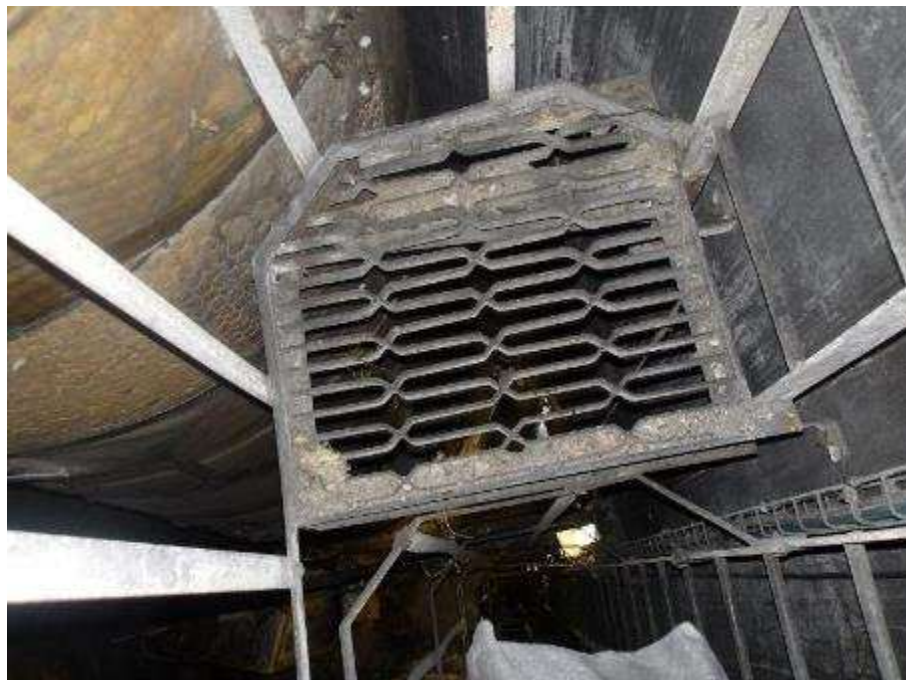
Photo n°100 : Echelle à crinoline et paliers de repos en bon état
