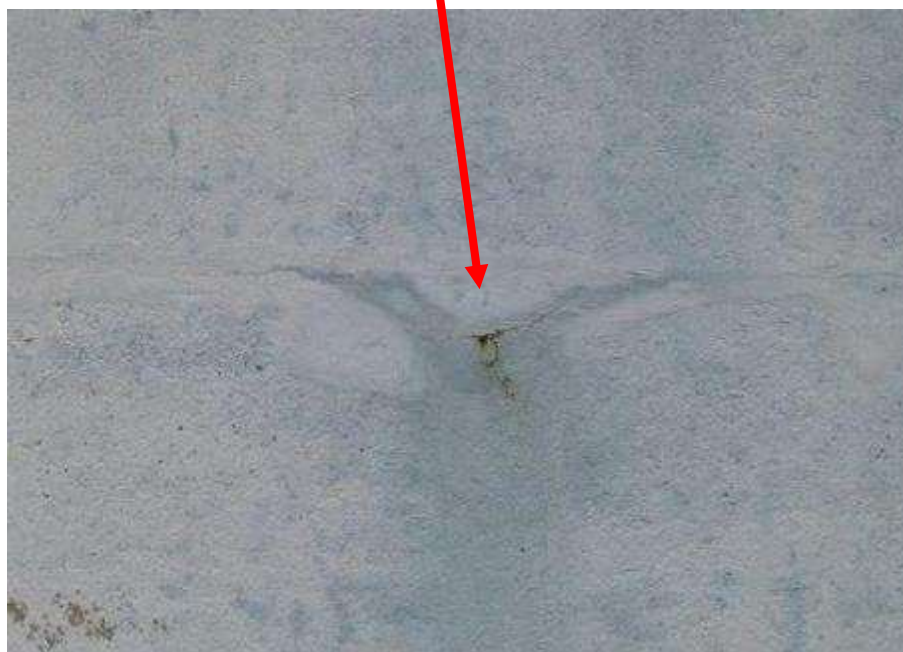
Photo n°36 : Armature métallique affleurante.
