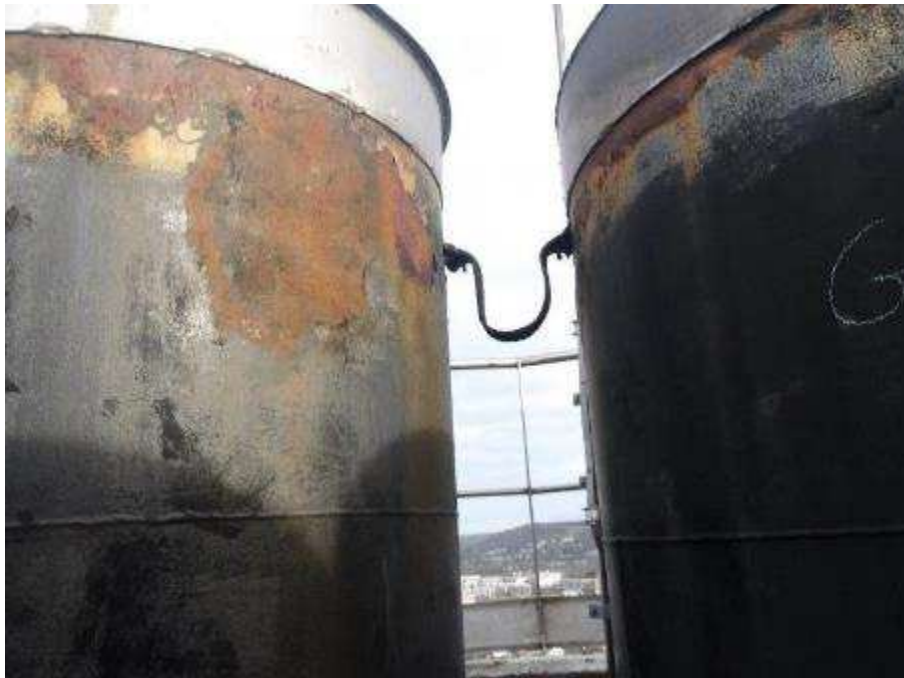
Photo n°86 : Fourreaux de passage des conduit connectés au système de paratonnerre. Fourreaux de passage des conduit oxydés (à repeindre)
