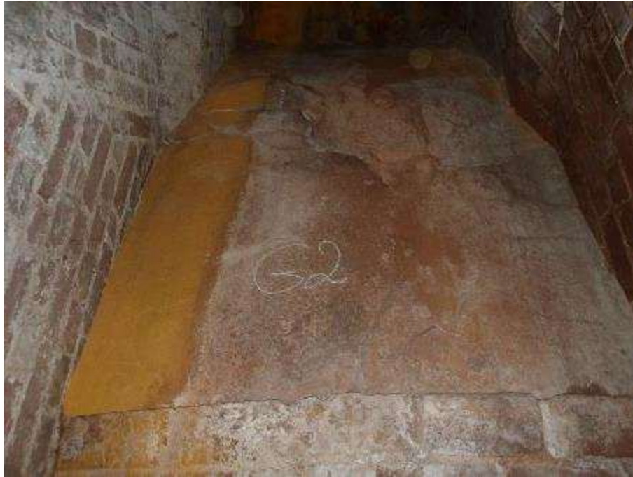
Photo n°210 : Carneau brique en état correct. Remontée vers la chaudière en béton réfractaire (bon état)
