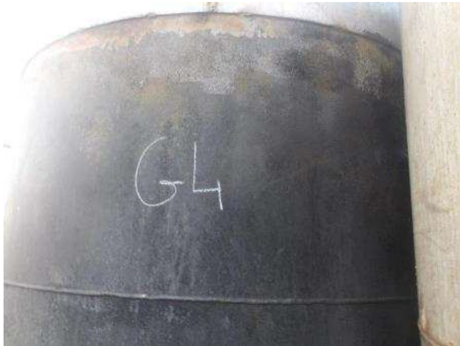
Photo n°251 : Fourreau de passage du conduit oxydé.
