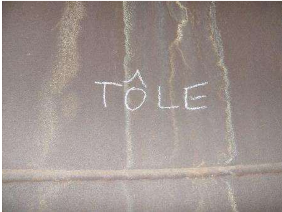
Photo n°116 : Conduit en bon état
