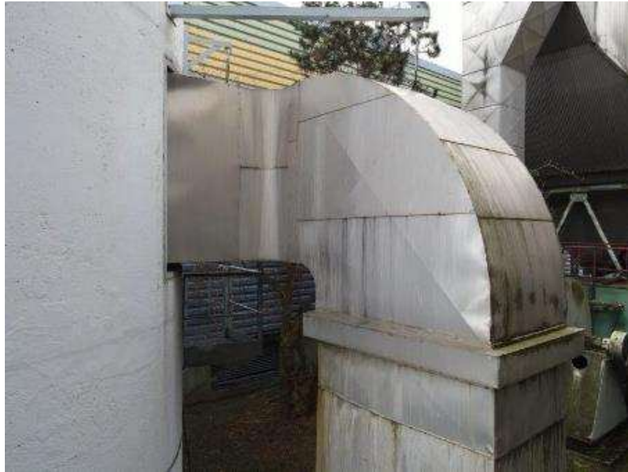
Photo n°57 : Bardage du carneau G3 en bon état
