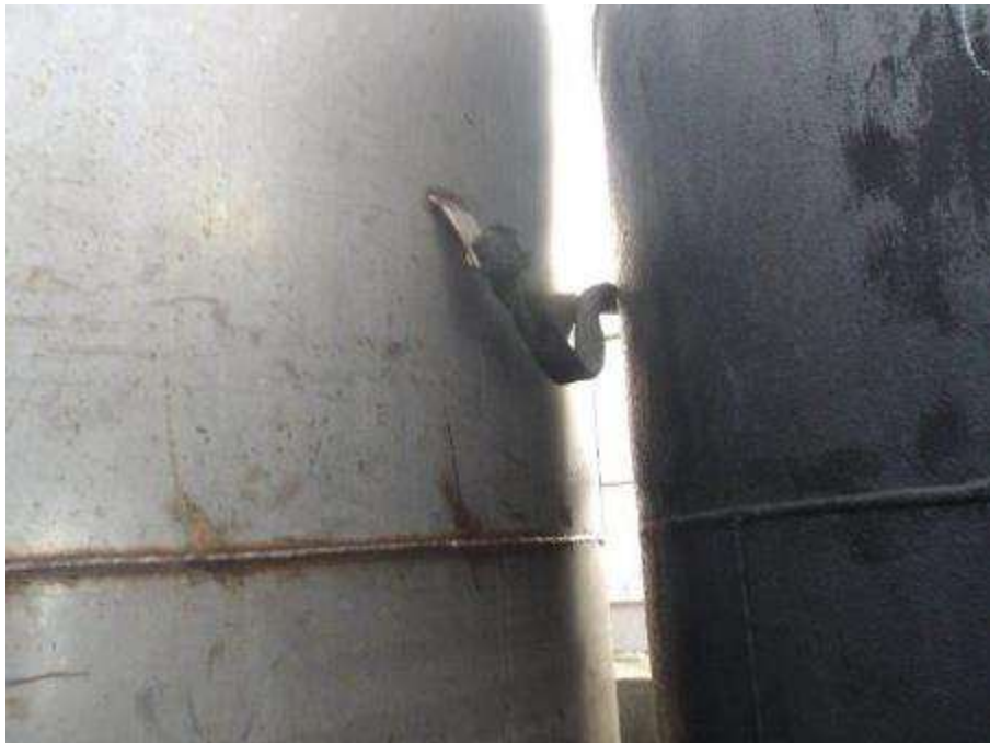
Photo n°84 : Fourreaux de passage des conduit connectés au système de paratonnerre
