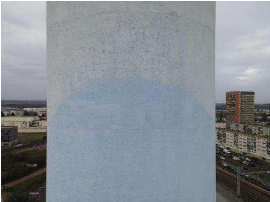
Photo n°34 : Fût béton en bon état, peinture légèrement passée.
