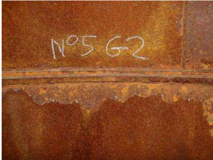
Photo n°170 : Assemblage et conduit en bon état
