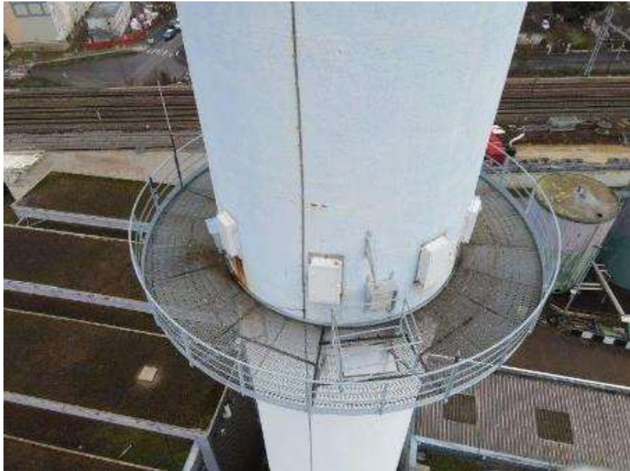
Photo n°45 : Fût béton en bon état, peinture légèrement passée. Conducteur paratonnerre en bon état Passerelle en bon état
