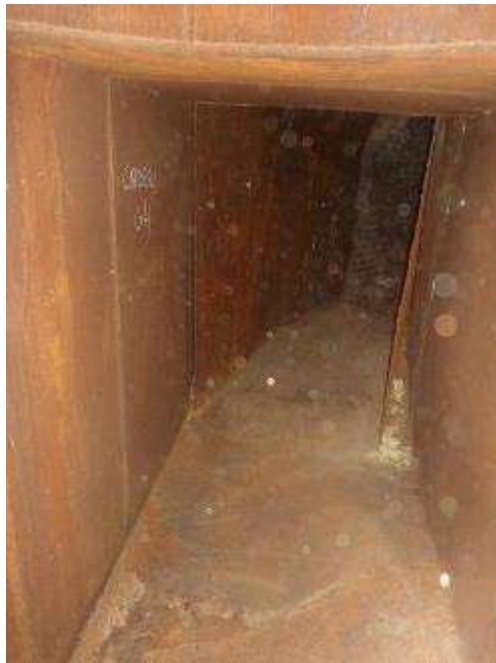
Photo n°257 : Carneau (partie Corten) en bon état.
