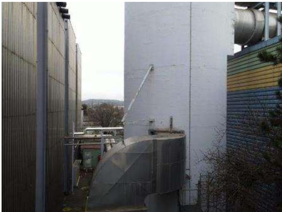
Photo n°54 : Fût béton en bon état, peinture légèrement passée. Conducteur paratonnerre en bon état
