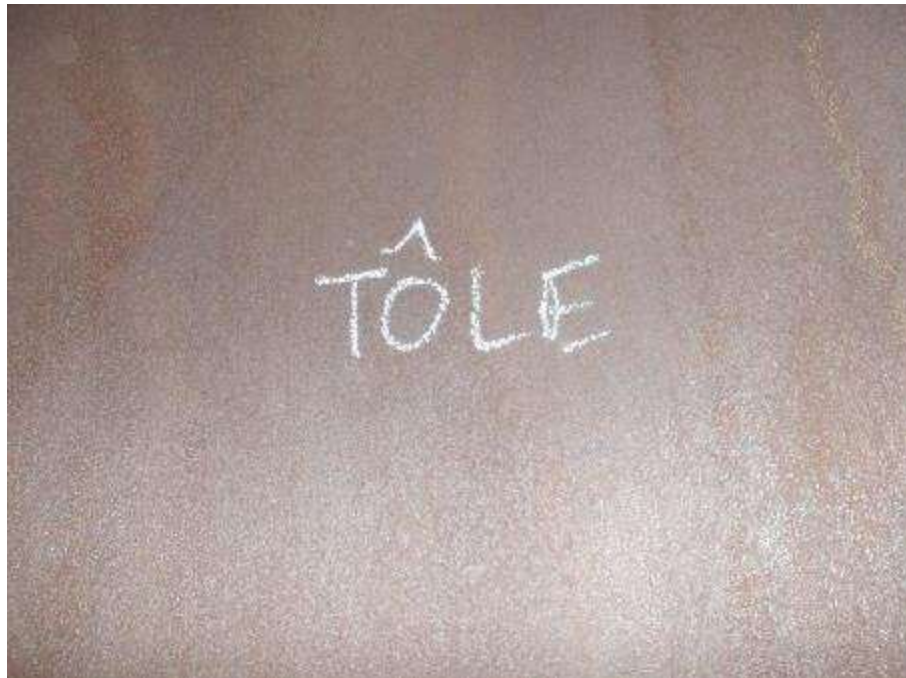
Photo n°135 : Conduit en bon état
