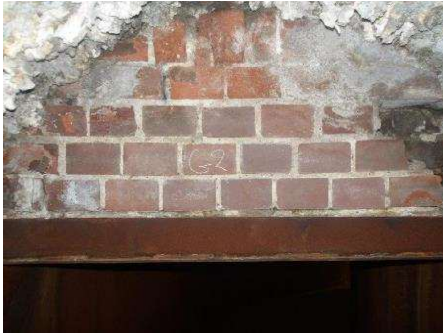
Photo n°204 : Carneau brique en état correct.
