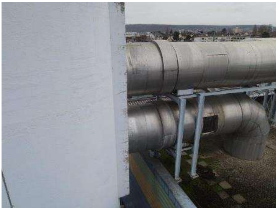
Photo n°52 : Fût béton en bon état, peinture légèrement passée. Renfort d'ouverture pour passage des carnaux en bon état.
