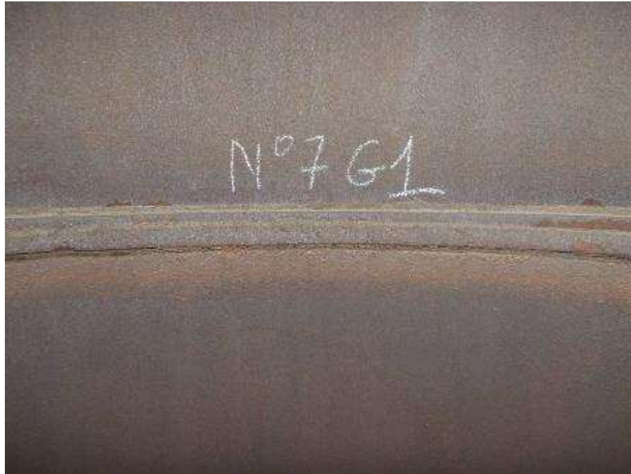
Photo n°126 : Assemblage et conduit en bon état
