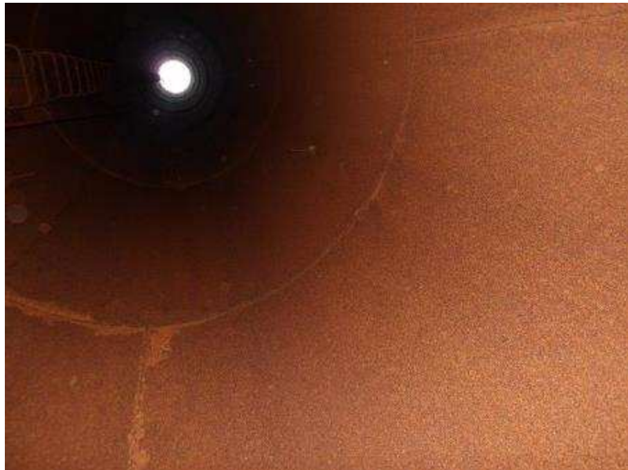
Photo n°171 : Conduit en bon état
