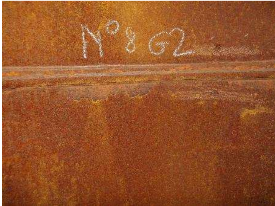
Photo n°174 : Assemblage et conduit en bon état
