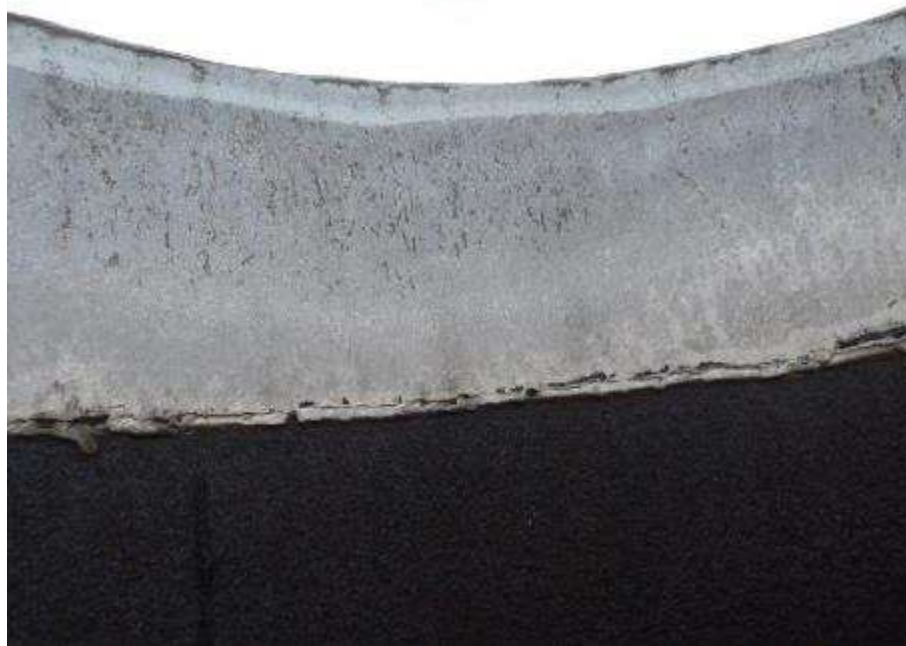
Photo n°142 : Bandeau Inox au sommet du conduit sur 200mm en bon état
