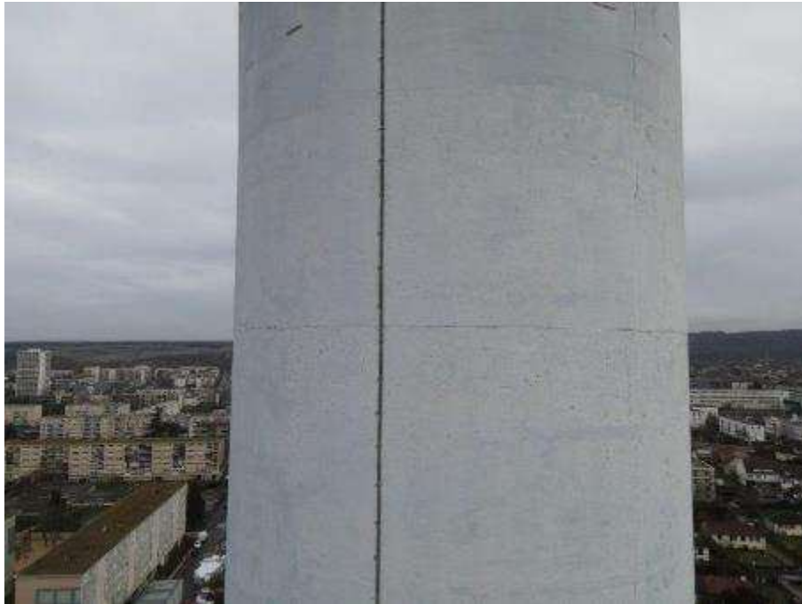
Photo n°41 : Fût béton en bon état, peinture légèrement passée. Conducteur paratonnerre en bon état
