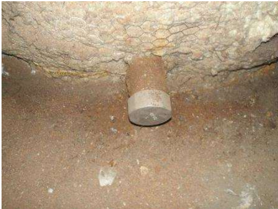
Photo n°216 : Tuyauterie d'évacuation des condensats équipé d'un bouchon. Bouchon à déposer et créer un exutoire pour les condensats
