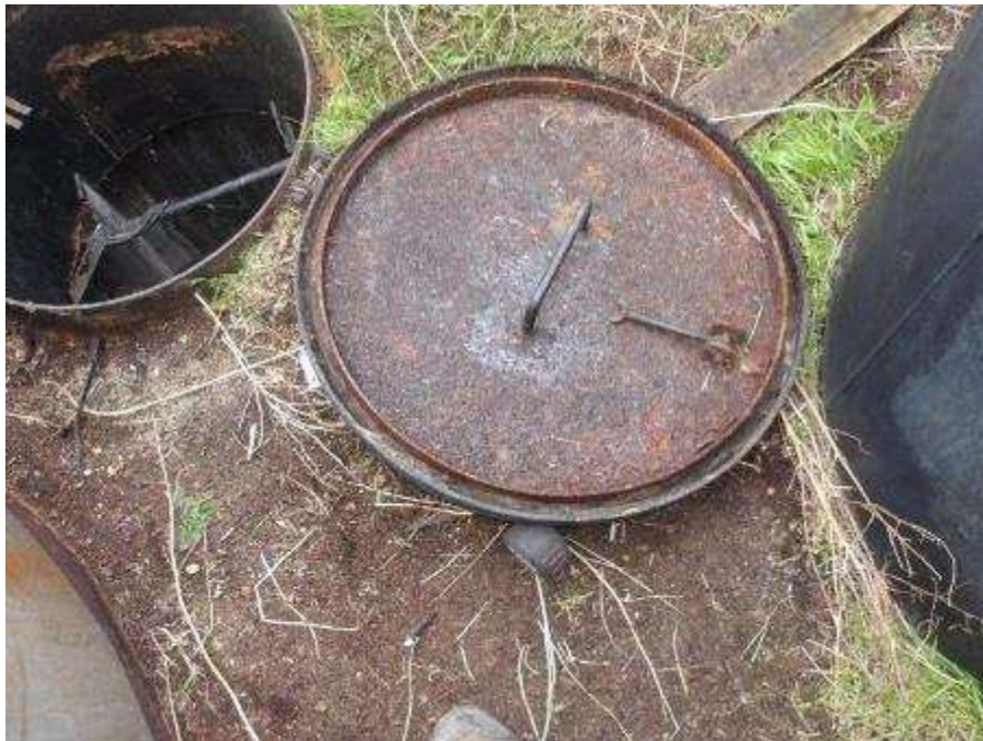
Photo n°75 : Tampon de la trappe d'accès oxydé sur la face intérieure mais fonctionnelle
