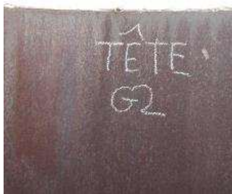
Photo n°191 : Sommet du conduit en bon état
