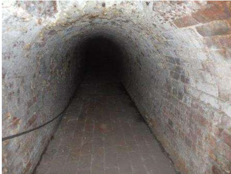
Photo n°150 : Carneau brique en état correct. Léger gonflement du sol.
