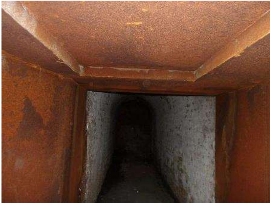
Photo n°202 : Carneau (partie en acier Corten) en bon état
