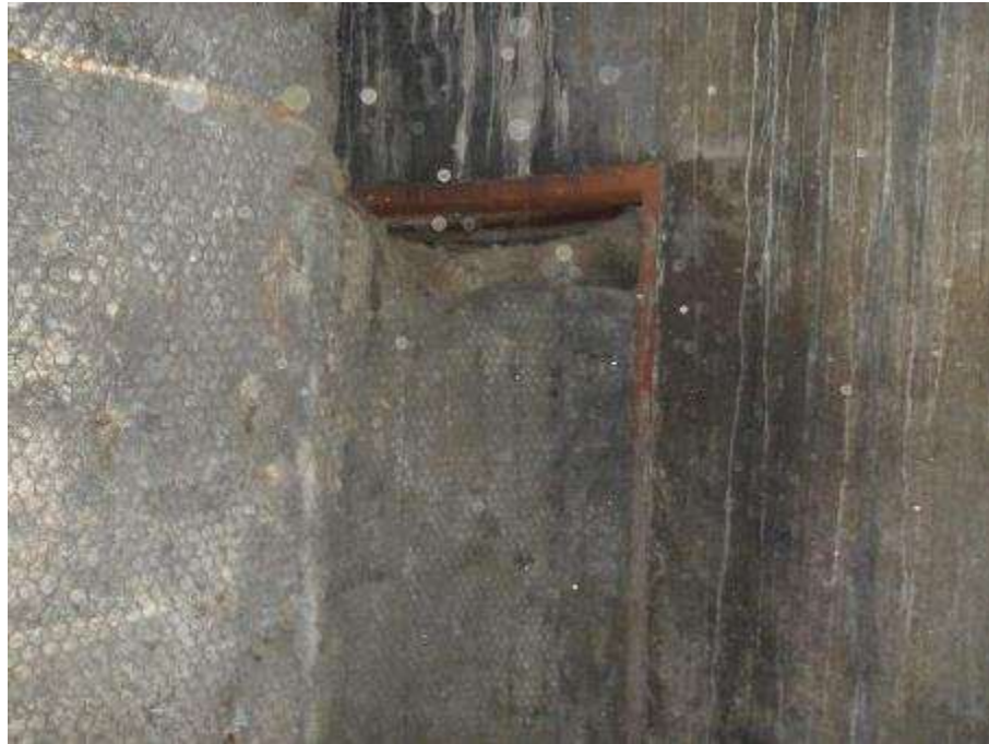
Photo n°218 : Piquage d'entrée des fumées en bon état
