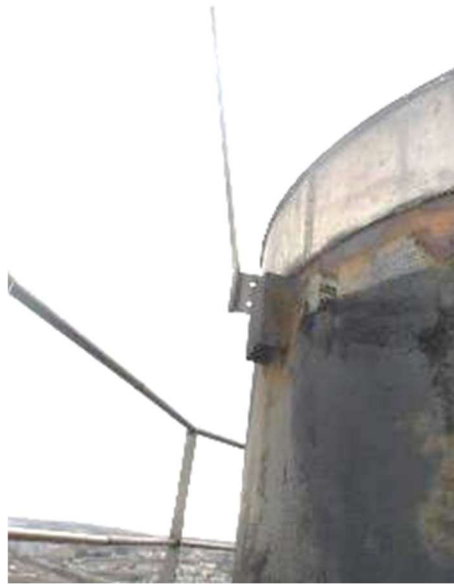
Photo n°194 : Pointe de paratonnerre en bon état
