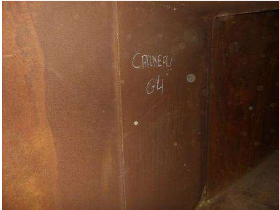
Photo n°256 : Carneau (partie Corten) en bon état.
