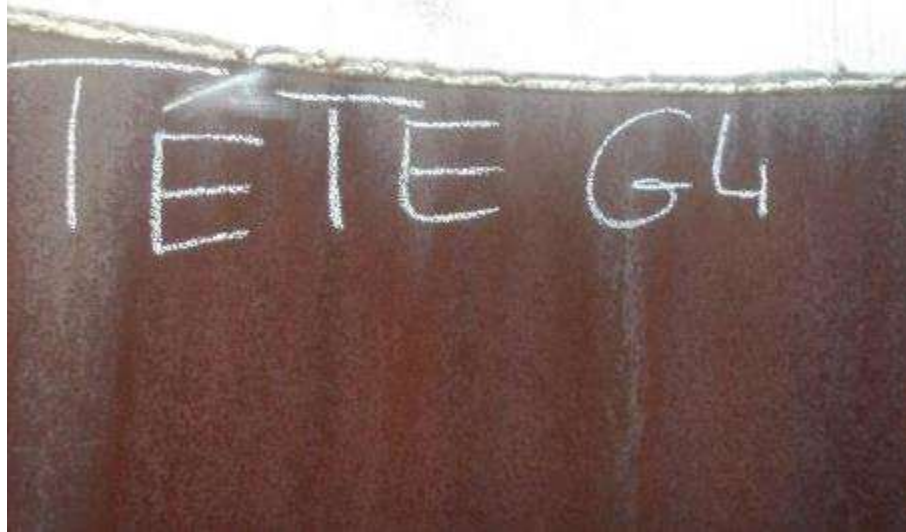
Photo n°248 : Sommet du conduit en bon état
