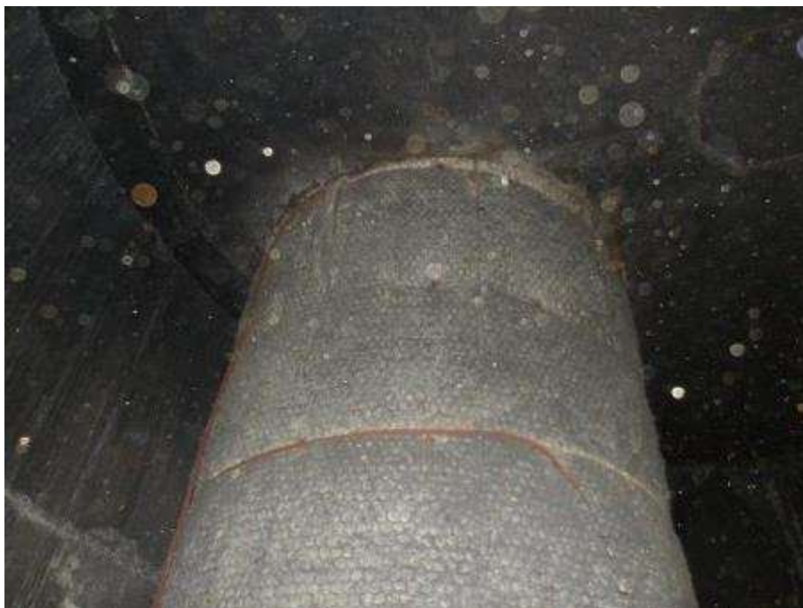
Photo n°217 : Isolation thermique du conduit en bon état.
