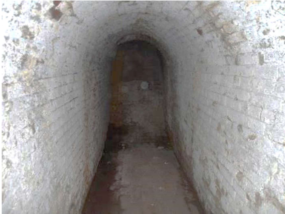
Photo n°208 : Carneau brique en état correct. Léger gonflement du sol.
