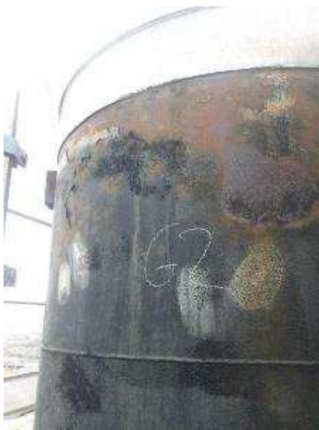
Photo n193° : Fourreau de passage du conduit oxydé (à repeindre)
