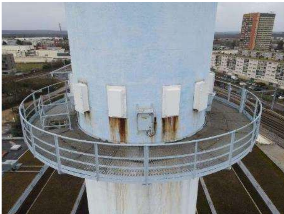
Photo n°32 : Passerelle en bon état, fût béton en bon état, peinture légèrement passée. Coulures venant de la passerelle et des prises de mesures.
