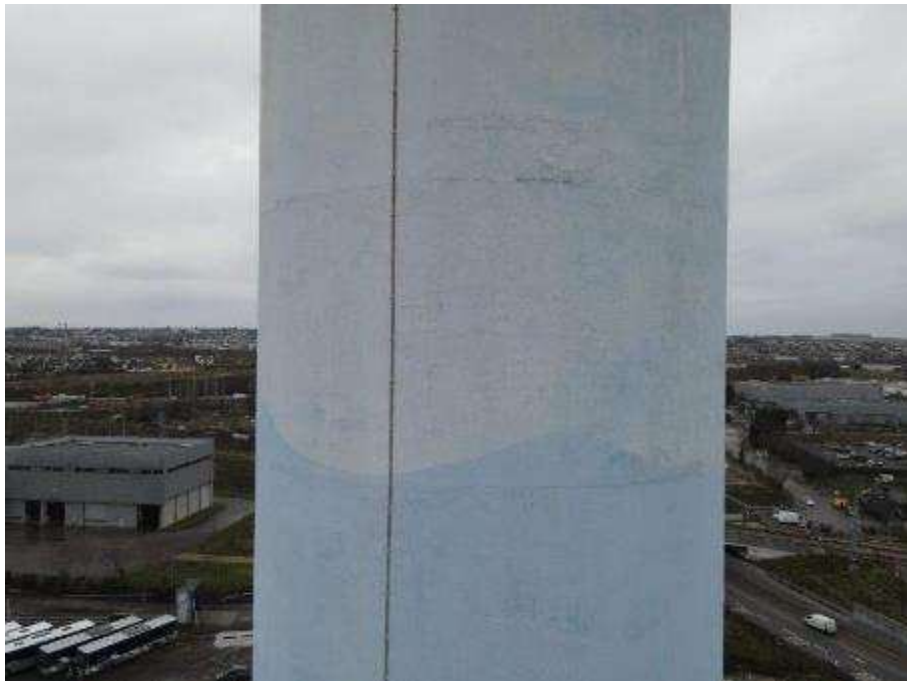
Photo n°14 : Fût béton en bon état, peinture légèrement passée. Conducteur paratonnerre en bon état
