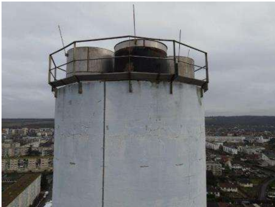
Photo n°40 : Fissuration multiple en partie haute.
