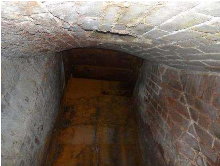
Photo n°211 : Carneau brique en état correct. Remontée vers la chaudière en béton réfractaire (bon état)
