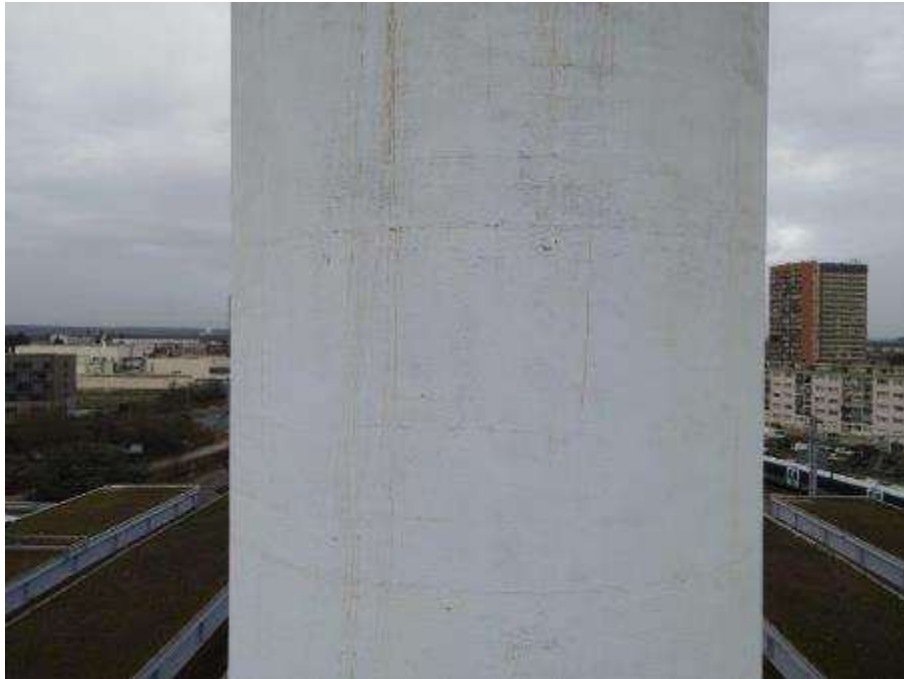
Photo n°27 : Fût béton en bon état, peinture légèrement passée.
