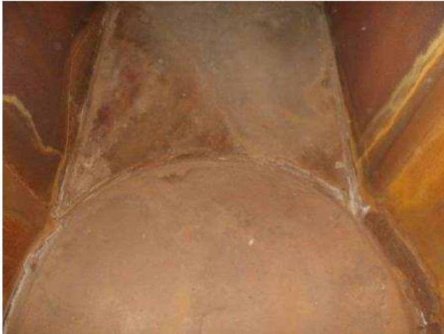
Photo n°198 : Carneau (partie en acier Corten) en bon état
