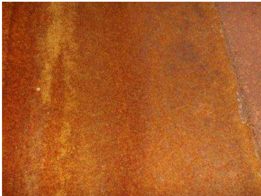
Photo n°171 : Conduit en bon état
