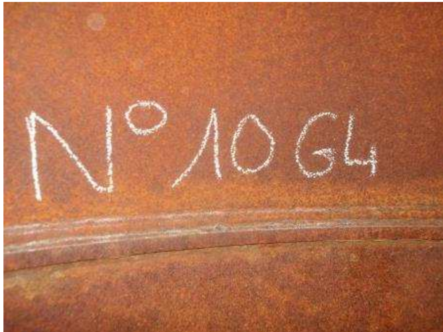
Photo n°235 : Assemblage et conduit en bon état
