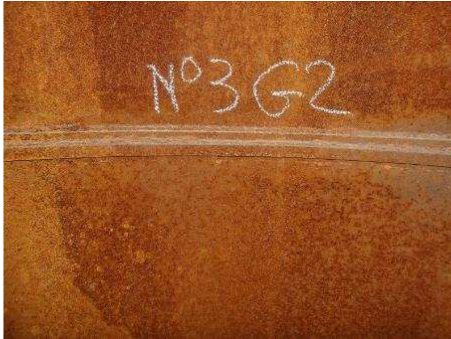
Photo n°168 : Assemblage et conduit en bon état
