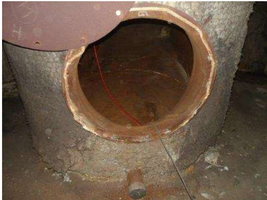
Photo n°215 : Trappe de visite en bon état
