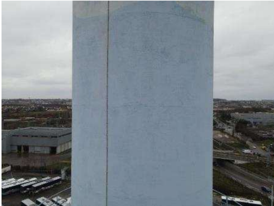
Photo n°15 : Fût béton en bon état, peinture légèrement passée. Conducteur paratonnerre en bon état
