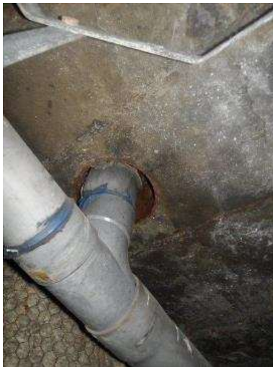
Photo n°90 : Tuyauterie d'évacuation des eaux pluviales en bon état.
