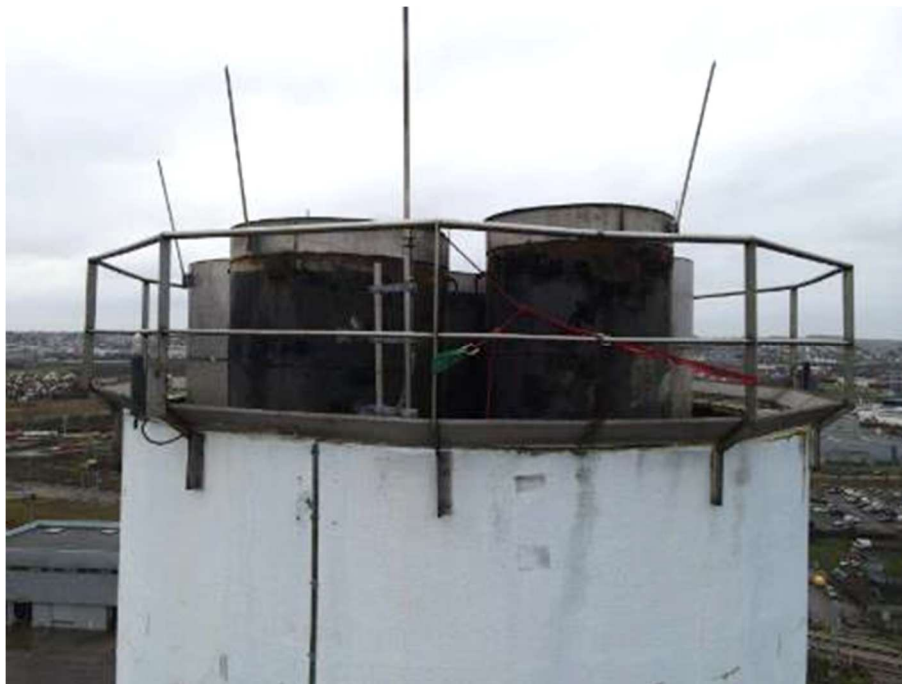
Photo n°11 : Garde-corps eu sommet en bon état (Inox). Système de paratonnerre en bon état.
