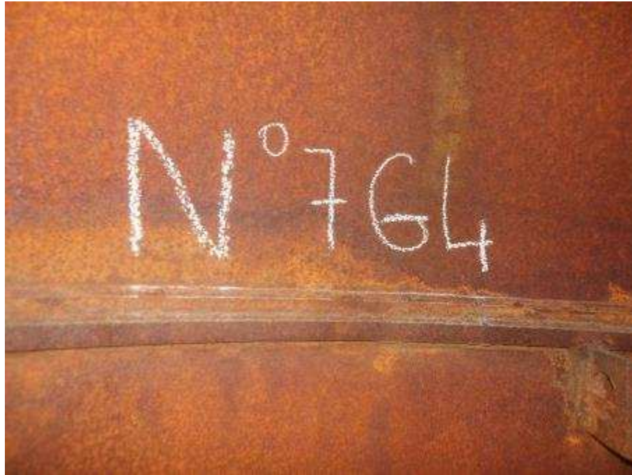
Photo n°232 : Assemblage et conduit en bon état
