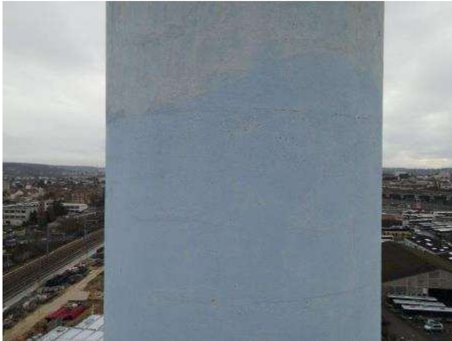
Photo n°67 : Fût béton en bon état, peinture légèrement passée.
