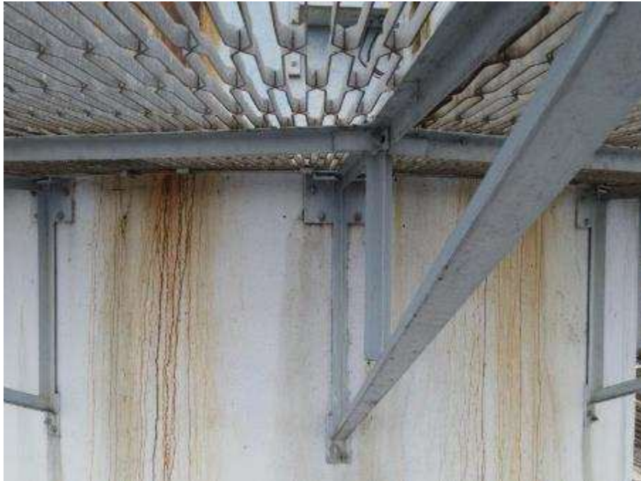
Photo n°29 : Passerelle en bon état, fût béton en bon état, peinture légèrement passée. Coulures venant de la passerelle et des prises de mesures.
