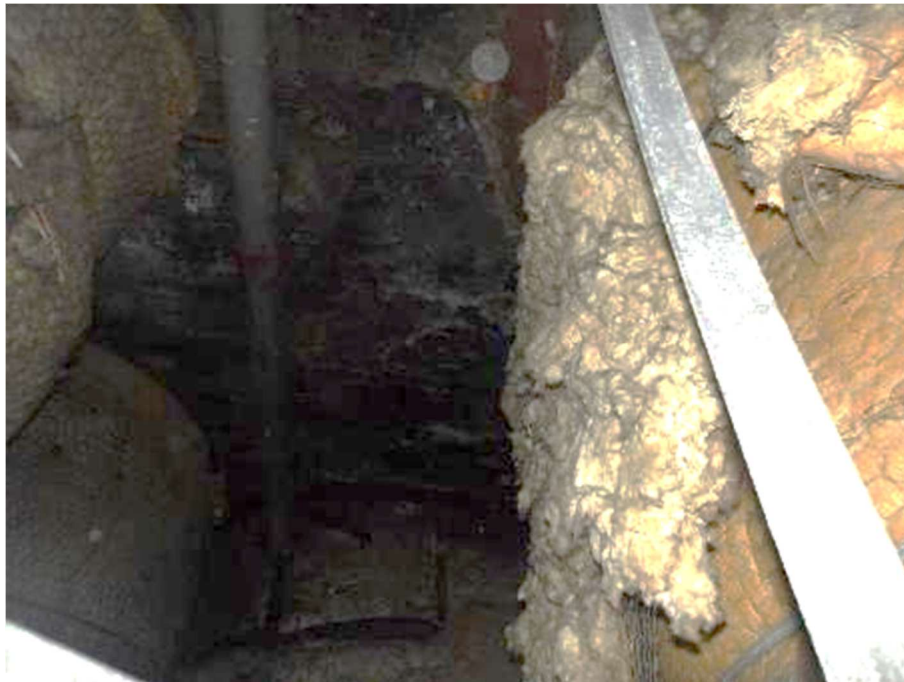
Photo n°94 : Isolant thermique du conduit G3 à reprendre sous la dalle sommitale.
