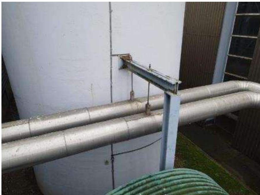
Photo n°24 : Support de tuyauterie en bon état et relié à la Terre.
