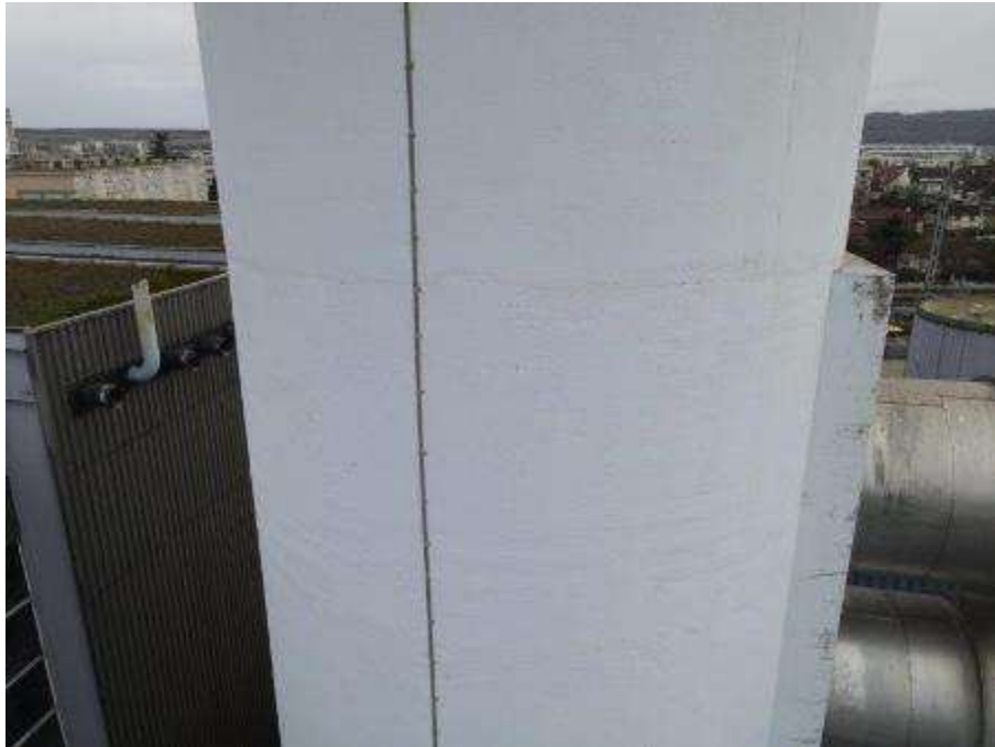
Photo n°51 : Fût béton en bon état, peinture légèrement passée. Conducteur paratonnerre en bon état
