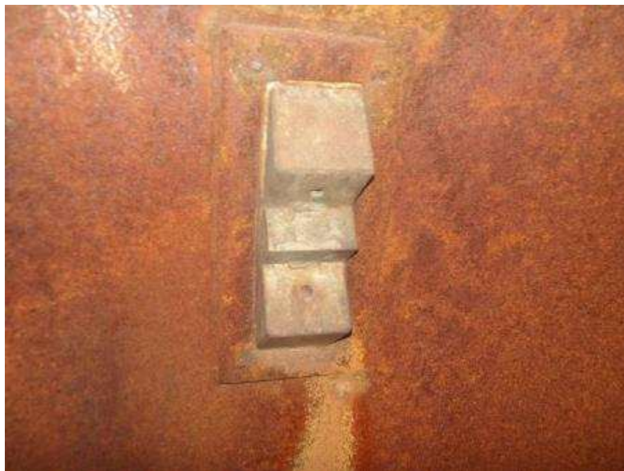
Photo n°236 : Opastop en bon état
