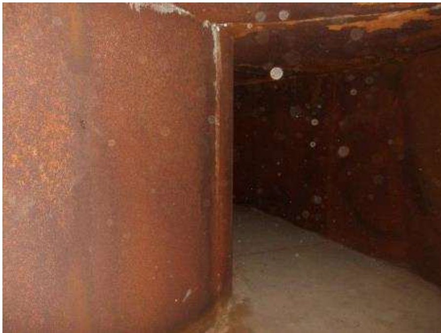
Photo n°199 : Carneau (partie en acier Corten) en bon état
