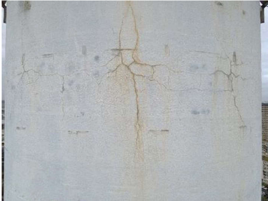
Photo n°4 : Fissuration importante du béton sur environ 1.5m de hauteur et sur 360
