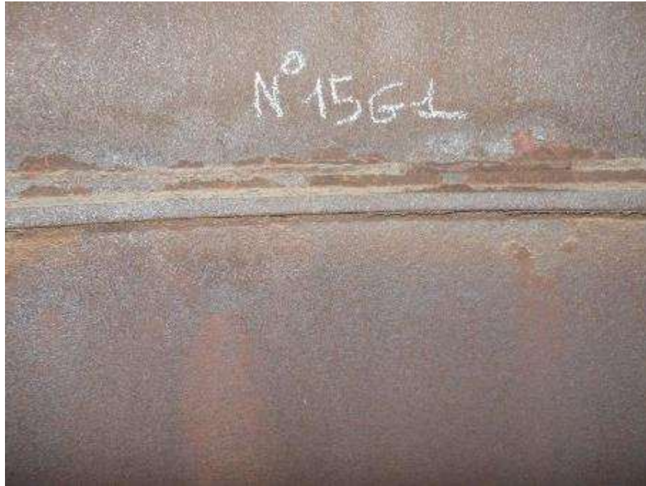
Photo n°138 : Assemblage et conduit en bon état
