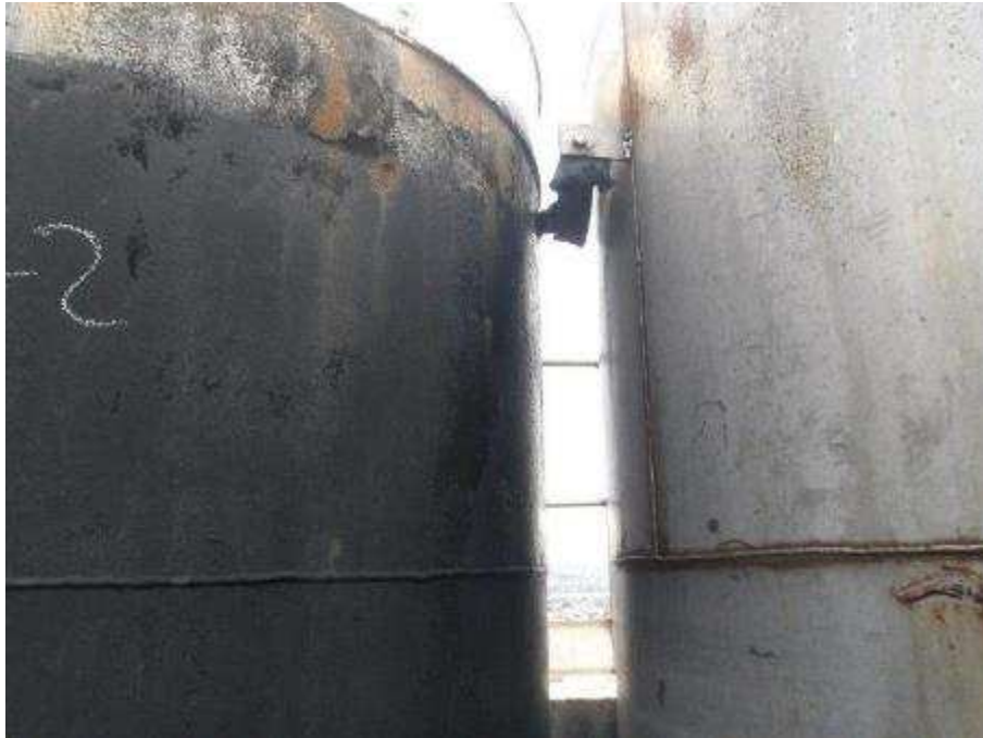
Photo n°85 : Fourreaux de passage des conduit connectés au système de paratonnerre. Fourreaux de passage des conduit oxydés (à repeindre)
