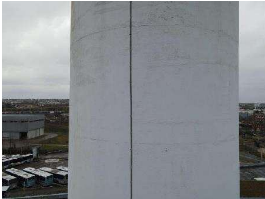
Photo n°20 : Fût béton en bon état, peinture légèrement passée. Conducteur paratonnerre en bon état
