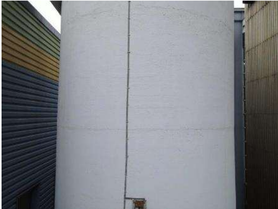
Photo n°23 : Fût béton en bon état, peinture légèrement passée. Conducteur paratonnerre en bon état
