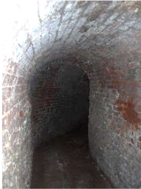
Photo n°261 : Carneau brique en état correct. Sol légèrement gonflé.
