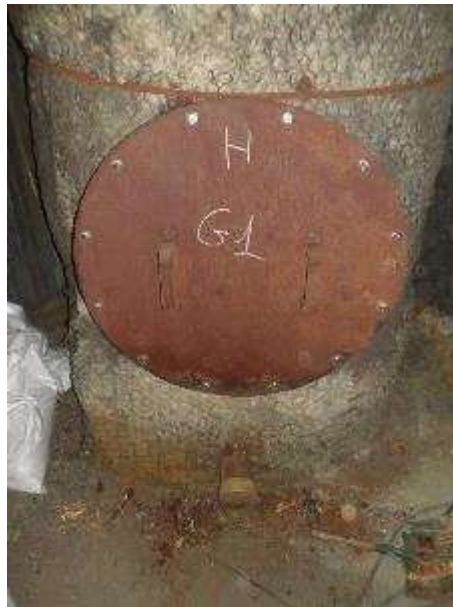
Photo n°155 : Tampon de la trappe de visite refermé après contrôle.
