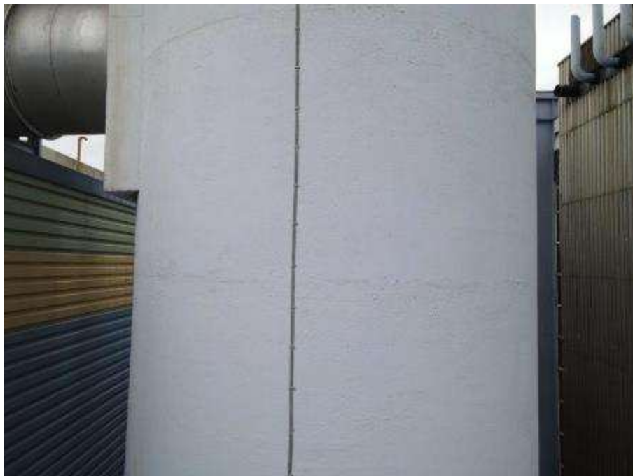
Photo n°22 : Fût béton en bon état, peinture légèrement passée. Conducteur paratonnerre en bon état
