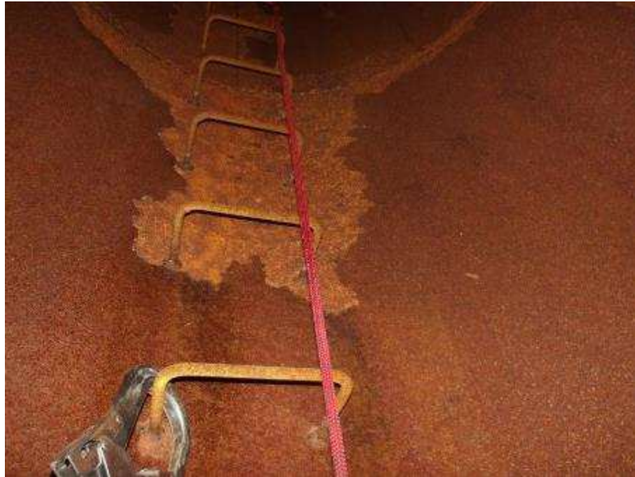
Photo n°180 : Conduit en bon état
