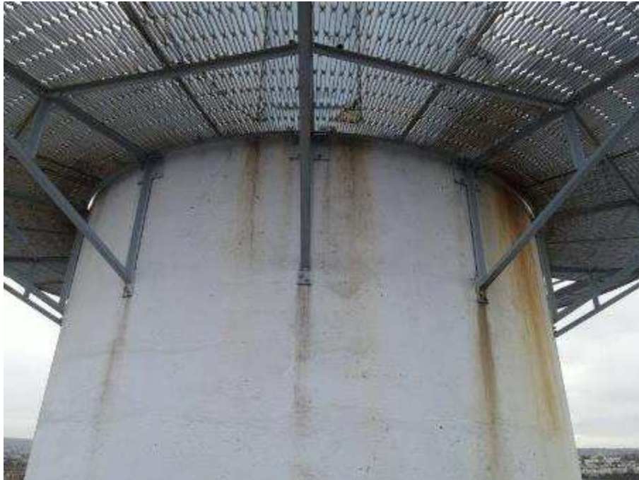
Photo n°63 : Passerelle en bon état, fût béton en bon état, peinture légèrement passée. Coulures venant de la passerelle et des prises de mesures.
