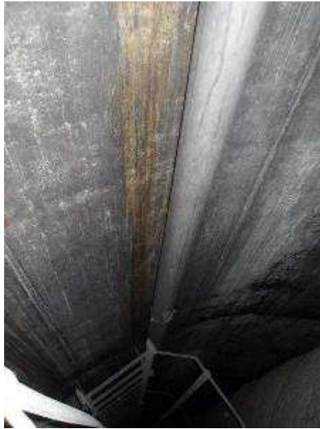
Photo n°93 : Tuyauterie d'évacuation des eaux pluviales en bon état.
