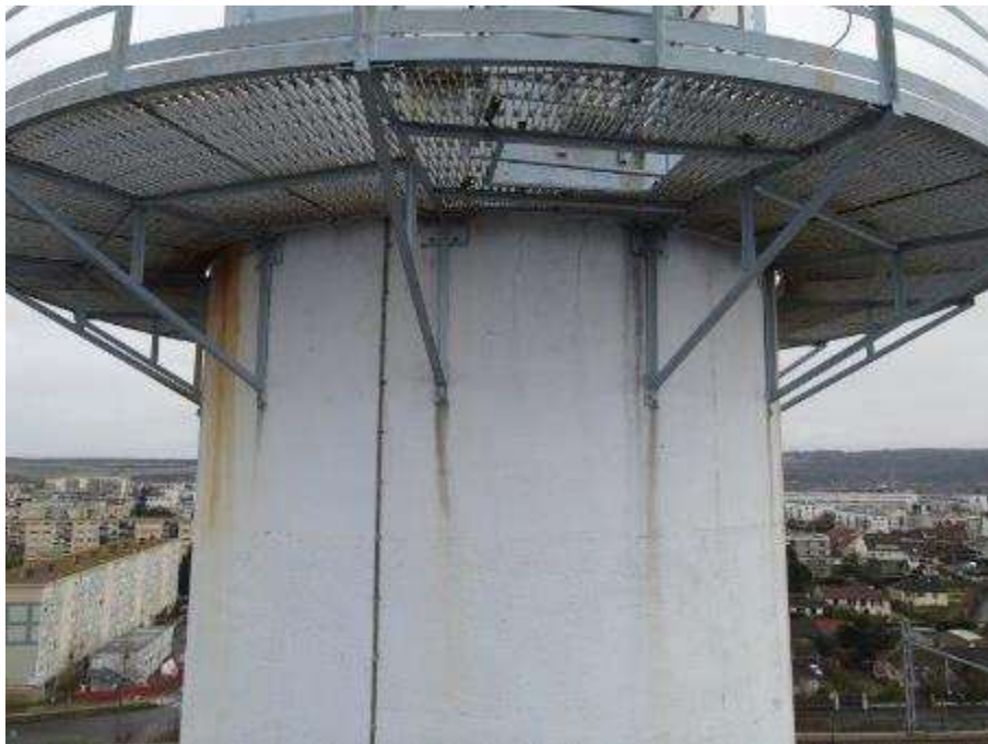
Photo n°48 : Passerelle en bon état
