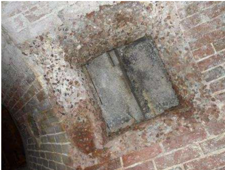
Photo n°212 : Trappe d'accès vers la chaufferie (en plafond)
