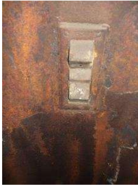
Photo n°130 : Opastop en bon état
